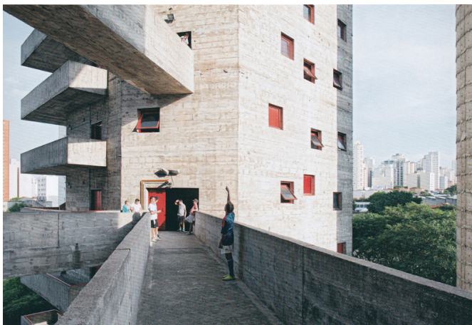
Abb.: 48 Verbindung der Türme
