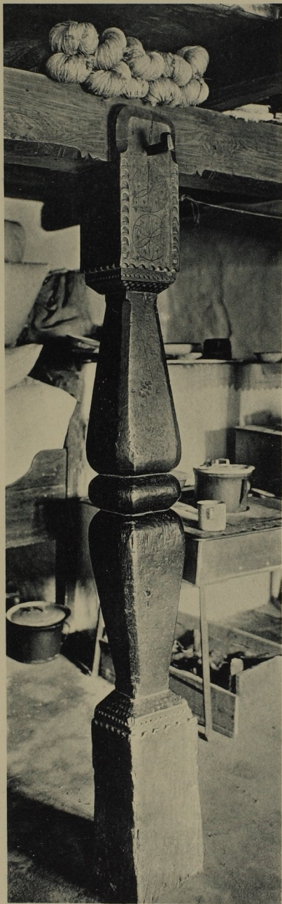
SÄULEN UNTER ROSTEN IN KÚTY.
