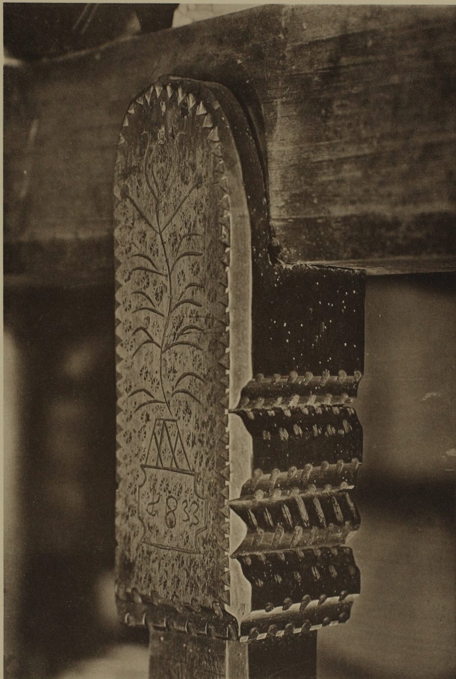
SÄULE UNTER DEM ROST IN KÚTY.
