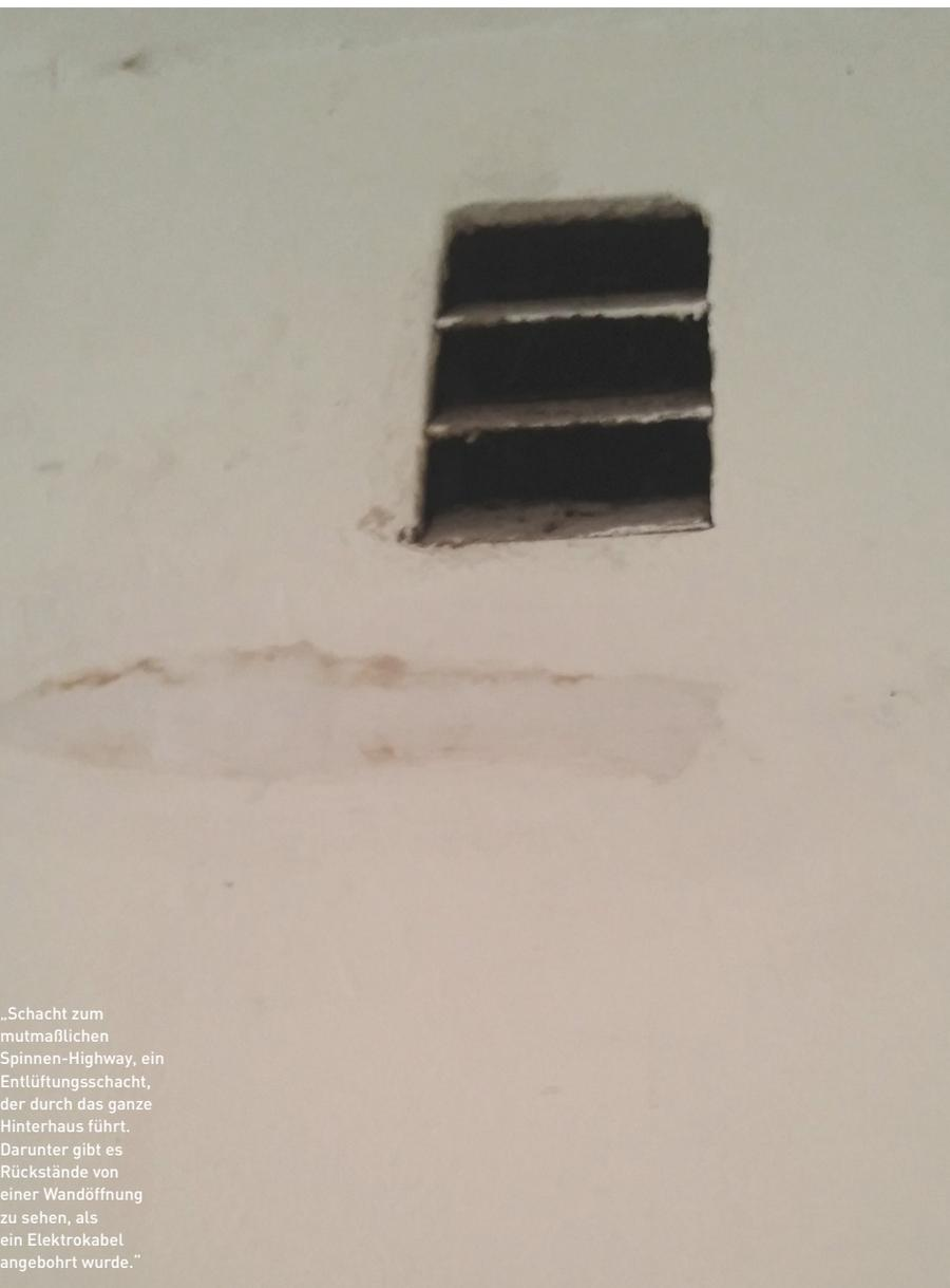
„Schacht zum mutmaßlichen Spinnen-Highway, ein Entlüftungsschacht, der durch das ganze Hinterhaus führt. Darunter gibt es Rückstände von einer Wandöffnung zu sehen, als ein Elektrokabel angebohrt wurde.“
