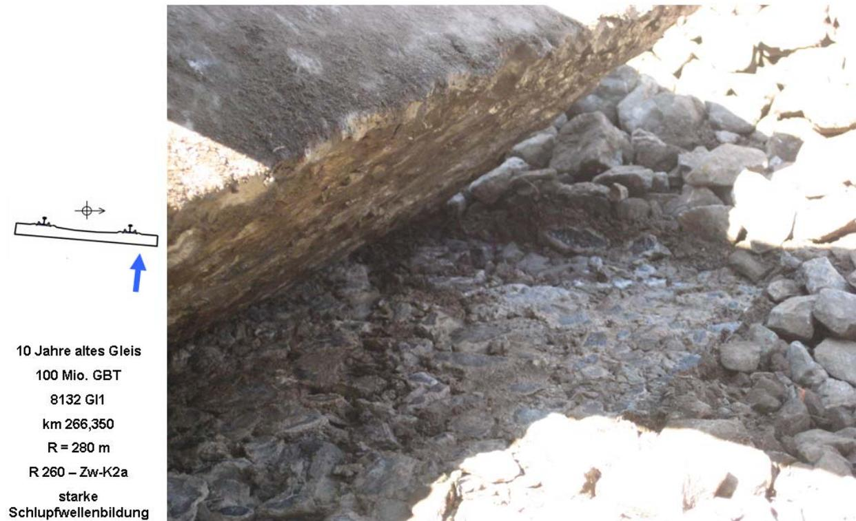
Abb. 1.93: An der Schwellenunterseite von unbesohnten Betonschwellen wird in schlupfwellenbehafteten Bogengleisen eine rasche Schotterzerstörung beobachtet.
