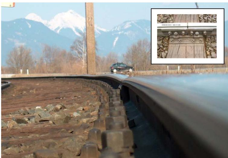
Schienenstöße stellen eine Unstetigkeitsstelle im Aufbau des Gleises dar. Die Stoßlücke verursacht vor allem im Winter einen zusätzlichen vertikalen „Schlag“ auf das Gleis. Je nach Rahmenbedingungen kommt es mehr oder weniger rasch zu einer Verschlechterung der Gleislagequalität und zu einer Verminderung der Standzeiten der Gleiskomponenten.
