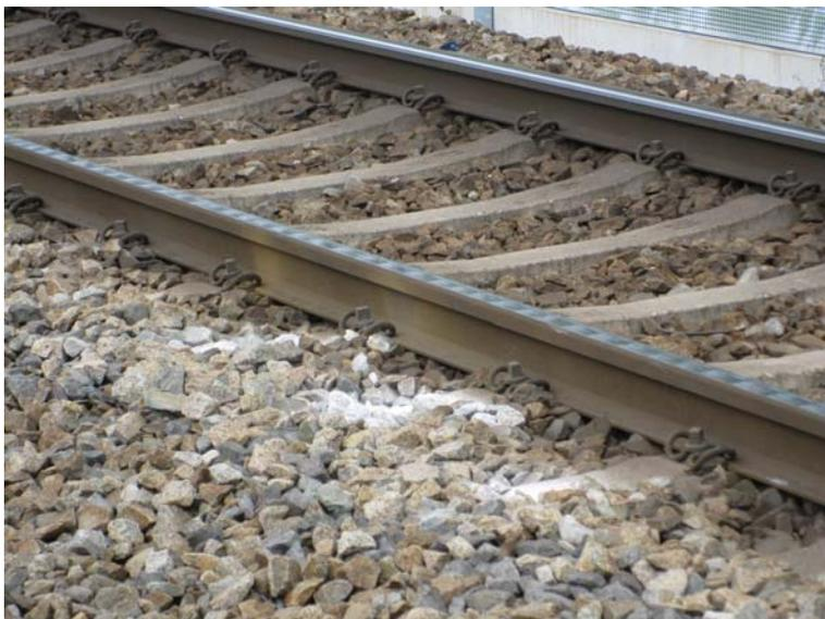
Phänomen der Schlupfwellenbildung (Abb. 1.89) an der bogeninneren Schiene. Die zyklischen Schienenoberflächenfehler weisen eine Wellenlänge von 10 bis 25 cm auf, die Amplitude kann dabei bis zu 0,4 mm und mehr betragen. Gleise mit starker Schlupfwellenbildung sind um ca. 15 dB lauter als schlupfwellenfreie Gleise.
