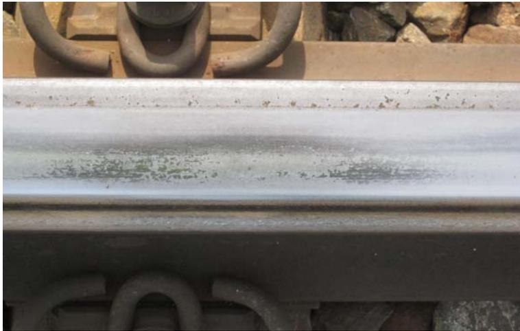
Abb. 1.90: Bei fortgeschrittener Schlupfwellenbildung kommt es auch bogenaußen zur Bildung von wellenartigen Schienenoberflächenfehlern.
