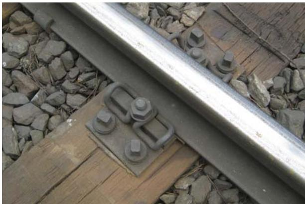
Abb. 1.15: Seit 1988 wird bei Holzschwellengleisen die Spannklemme Skl 12 als federndes Element eingesetzt. Der Durchschubwiderstand bleibt damit lange ausreichend groß.
