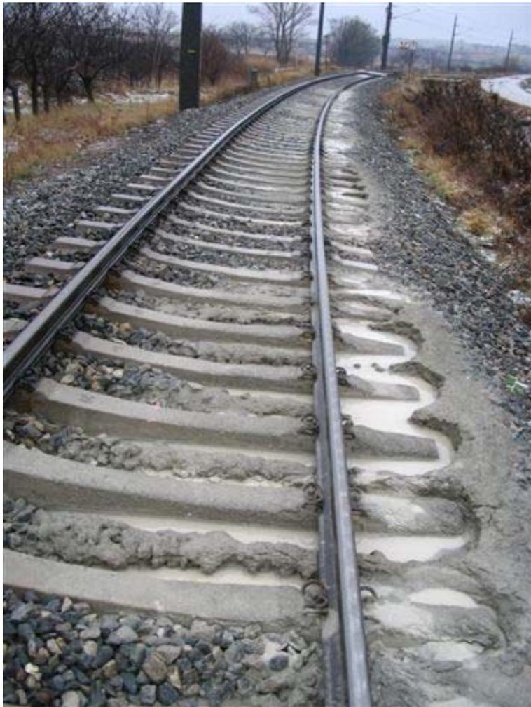
verhindert eine Ableitung der Niederschlagswässer, es entstehen Spritzstellen, die alleine vom Schotterabrieb verursacht sind, die Tragschichtoberkante ist trocken und voll funktionsfähig. Die Ursache für die Spritzstelle lässt sich an der grauen Färbung des Schotterabriebs erkennen (Abb. 1.94).
