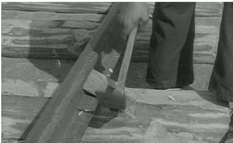
Abb. 1.2: Der eingeschlagene Holzkeil zwischen Schienenkopf und Holzschwelle sorgte bei alten Bogengleisen für einen Kippschutz der Schienen. (entnommen dem Film Kronans rallare)
