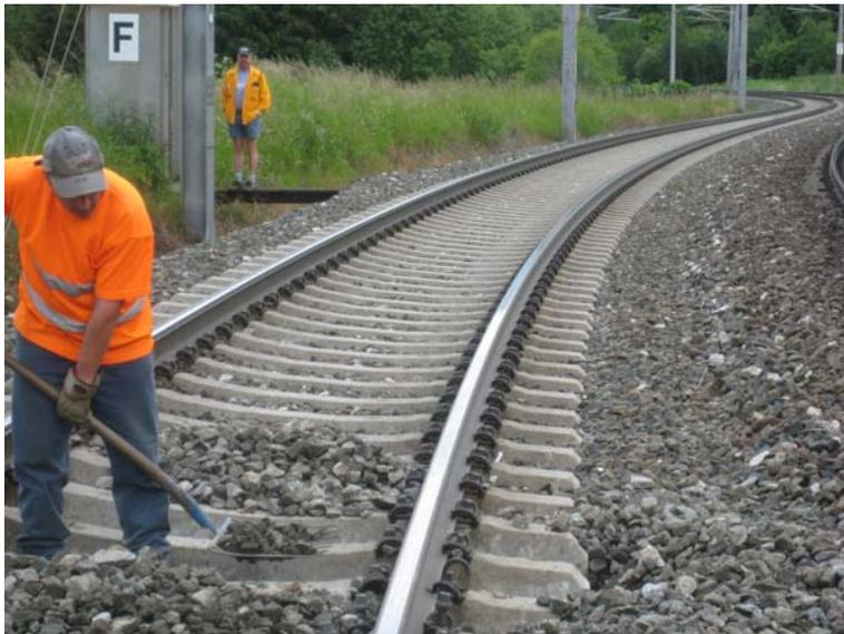
Grund für die beginnende Schlupfwellenbildung könnten in der Versteifung der Zwischenlagen bzw. im Lockern der Schwellenschrauben liegen (alter Schraubdübel Sdü 21). NATAS-Analyseblätter und Detailbericht siehe Anhang 9.
