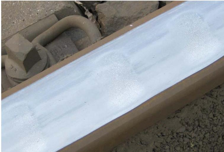
*Abb. 2.88: Im Bereich von Schlupfwellen kommt es zu hohen Relativgeschwindigkeiten der Kontaktpartner.*
