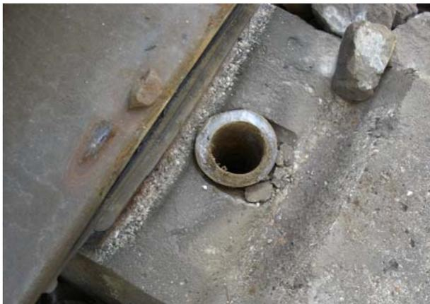
Abb. 1.82: Kriechvorgänge in Dübeln aus HDPE (Sdü 9, Sdü 20 und Sdü 21) führen im Laufe der Zeit zu einem Hochwandern des Dübels und damit zu Lockerungen in der Schraube-Dübel-Paarung. Es ist in Bögen daher besonders wichtig die Schwellenschrauben von Zeit zu Zeit nach zuziehen.
