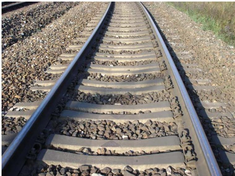
durchgehender elastischer Auflagerung. Das lückenlose Verschweißen auch enger Bögen (Bsp. Bf Eichberg,  $R = 179 \text{ m}$ ) ist damit möglich.
