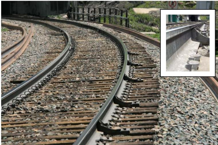
Abb. 1.9: Genagelte Holzschwellengleise (v.a. in den USA verwendet) weisen einen geringen Widerstand gegen Hochziehen der Nägel und damit seitliches Kippen der Schiene auf. Deshalb wird in diesen Gleisbögen auch heute noch ein Kippschutz angebracht. (Foto: DI Dr. Jochen Holzfeind)
