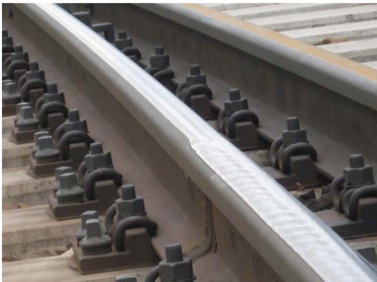
*Abb. 2.89: Der Vorteil der feinperlitierten Schienengüte (rechts unten) gegenüber der Standardgüte (links oben) ist augenscheinlich. In Bögen empfiehlt sich daher der Einsatz der Stahlsorte R 350 HT.*
