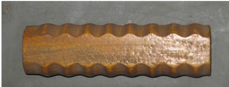
Abb. 1.79: Bei den Betonschwellen „BE 11“, „BE 12“ und „BE 14“ wurde ein Wellendübel aus Holz, und später auch aus Kunststoff, während der Produktion in die Betonschwelle eingebracht. Der Holzdübel hat sich als sehr langlebig erwiesen. Lockerungen der Schwellenschraube wurden durch ein Anziehen der Schrauben bei der „kleinen Instandhaltung“ beseitigt. (Foto: TMW)
