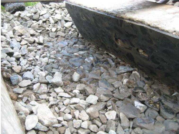
Abb. 1.56: Die Schonung des Schotterbetts durch den Einsatz von Schwellenbesohlungen ist „augenscheinlich“. Das Beispiel zeigt einen 280-m-Bogen bei Scheifling (Südbahn) nach 8 Jahren Betriebsbelastung.
