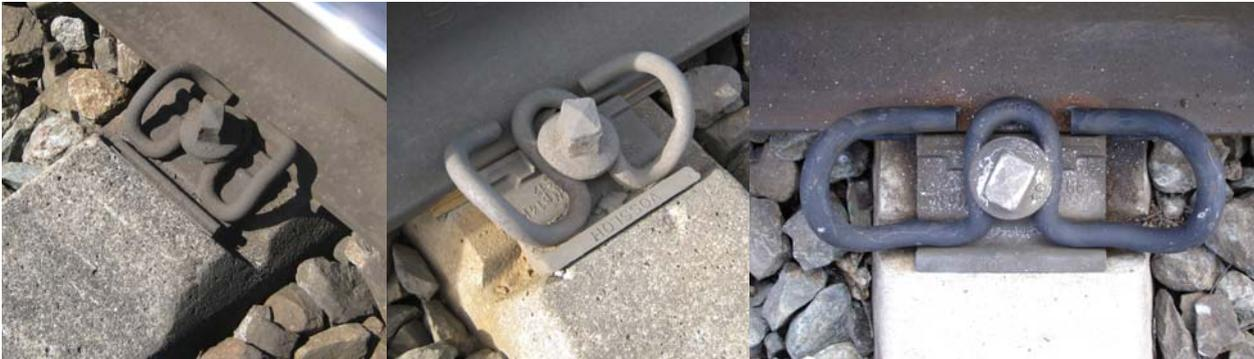
Abb. 1.67: Bei den ÖBB sind vornehmlich drei verschiedene Spannklemmentypen im Einsatz:
