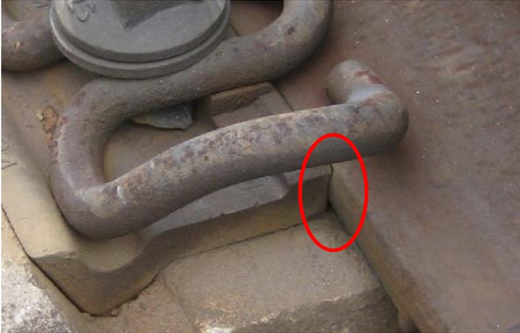
*Abb. 1.69: Unter Betrieb führen die Seitenkräfte in engen Bögen zu Einarbeitungen des Schienenfußes in die Kunststoff-Winkelführungsplatte (Bsp. Wfp 14 K - 12). Das Bild zeigt einen 300-m-Bogen bei Eichberg (Semmering) nach 150 Mio. Gesamtbruttotonnen*
