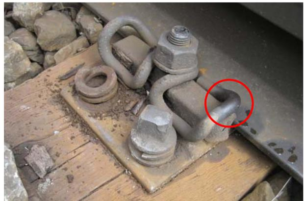
Abb. 1.16: In engen Bögen führen Einarbeitungen des Schienenfußes in die Rippenplatte zu Spurweiten-Vergrößerungen.
