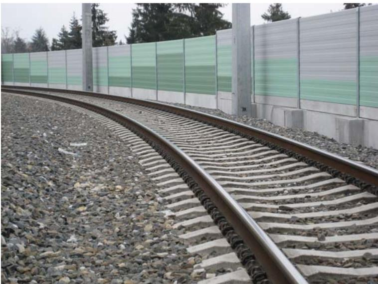
Abb. 2.93: Schlupfwellenfreies Bogengleis bei Sankt Pölten. Es kamen im 214-m-Bogen HDS-Schwellen zum Einsatz.
