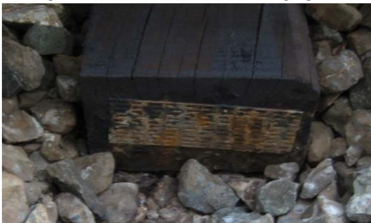
Das Imprägniermittel muss verschiedenen Anforderungen (Flammpunkt, Kristallisationstemperatur, Wassergehalt etc.) genügen. Vor allem ist der Anteil an als krebserregend eingestuft
