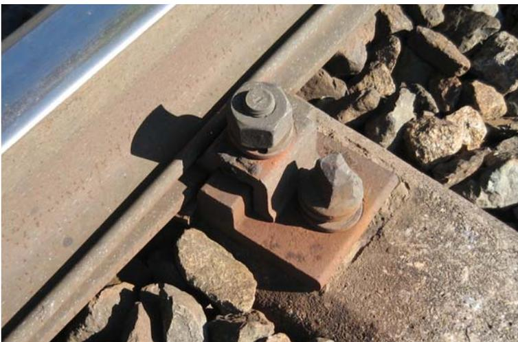
Abb. 1.62: Die K-Befestigung ist sehr robust und zeigte auch in Bogengleisen ein gutes Verhalten. Einpressungen der Rippenplatte in die Betonoberfläche finden erst spät statt, Auslöser sind meist Lockerungen der Schwellenschraube.
