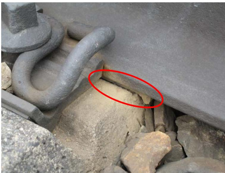
steif und weist eine Shore-C-Härte von 63 auf. Der Verschleiß in Bögen war zufriedenstellend, jedoch arbeitete sich die steife Zwischenlage unter Betrieb in den Auflagerbereich der Betonschwelle (Abb. 1.74).
