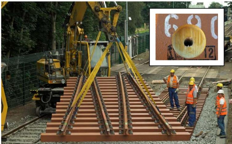
wird vornehmlich durch Fäulnis und durch Einpressungen der Rippenplatte bzw. Lockerungen der Schwellenschraube strapaziert.
