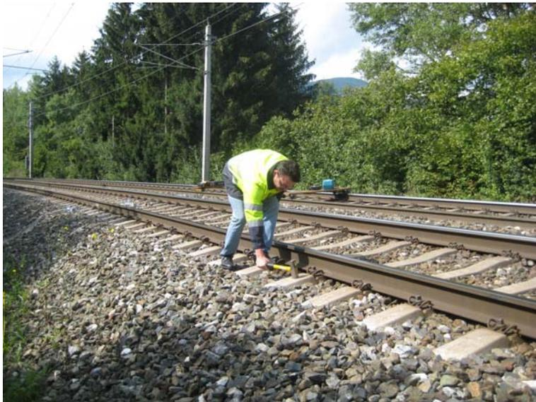
Abb. 2.84: Mittels Klangprobe wurde in einem Gleisbogen eine statistische Bestimmung der Hohllagenhäufigkeit durchgeführt.
