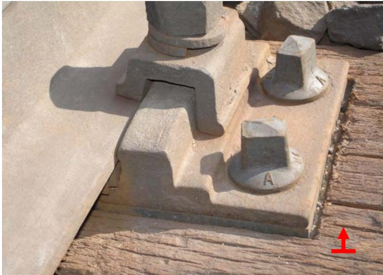
Der Einsatz von Kunststoffkeilplatten (Abb. 1.22) ermöglicht eine Korrektur der Fehlneigung der Rippenplatte.
