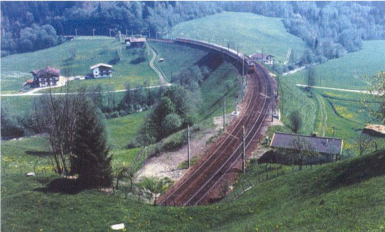
Abb. 2.56: 2001 fanden im Brixental umfangreiche Untersuchungen zur Schlupfwellenbildung statt. Besonderes Augenmerk wurde dem Gleis auf einer Stahlbrücke geschenkt, Obwohl das Gleis im engen Gleisbogen lag ( $R = 280\text{ m}$ ) waren auf der Stahlbrückenkonstruktion keine Schlupfwellen zu beobachten. [17]
