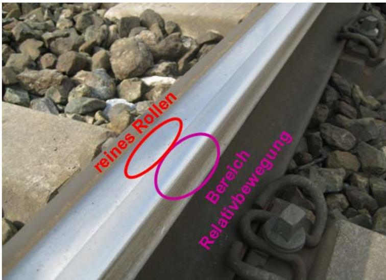
Abb. 2.29: Bogenäußere Schienen zeigen zwei unterschiedliche Kontaktbereiche. Im Bereich der grauen Fahrkante findet eine größere Relativbewegung zwischen Rad und Schienen statt, in Schienenkopfmittle findet ein reines Rollen statt.
