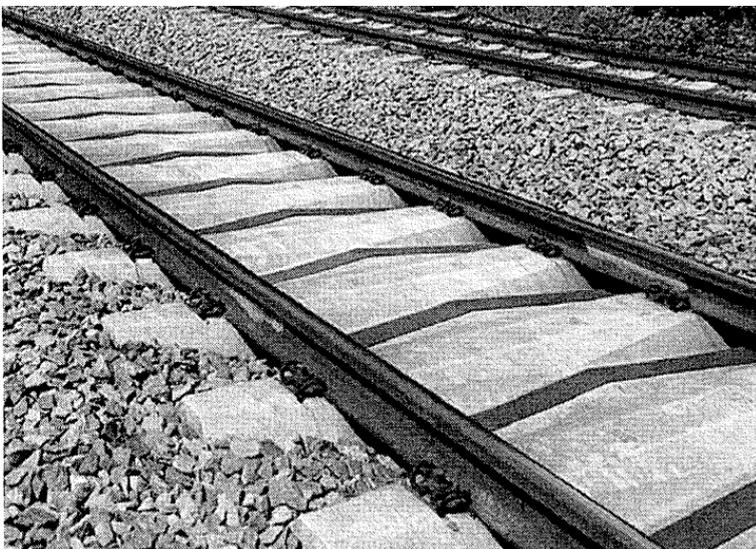
Abb. 1.47: Breitschwelle der DB, entwickelt 1996 von Unbehauen.
