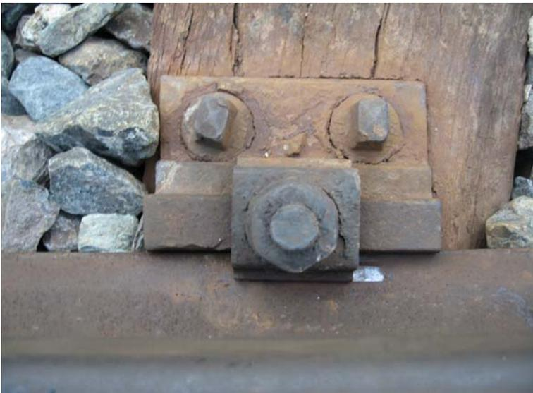
Abb. 1.14: In Gleisen mit Rippenplattenbefestigung und Klemmplatte ist die Durchführung der Stoßlückenberichtigung besonders notwendig, da bei leichtem Lösen der Hakenschrauben die lockere Klemmplatte den Durchschubwiderstand stark reduziert.
