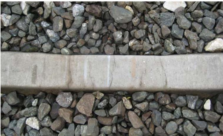
Die Vorspannung des Betons und die einsetzende Karbonatisierung schließt die Risse dann wieder, wenn diese nicht schon zu stark ausgeprägt sind. Die Nutzungsdauer des Gleises sinkt entsprechend dem Zerstörungsgrad der Schwelle.
