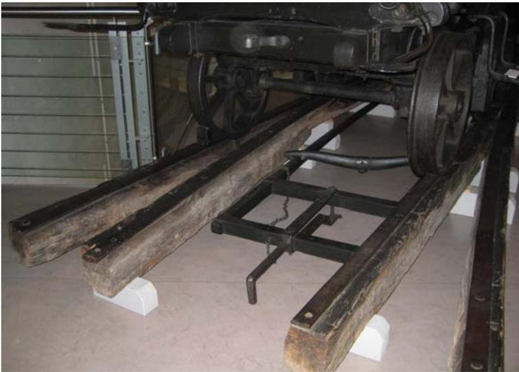
Abb. 1.3: Weichenkonstruktion mit Flachschienen auf der «Holz- und Eisenbahn» Mauthausen (später Linz) nach Budweis. Diese Konstruktion, anfangs auch auf der Nordbahn eingesetzt, hielt einem Lokomotiv-Betrieb nicht Stand. (Ausstellungsstück TMW)
