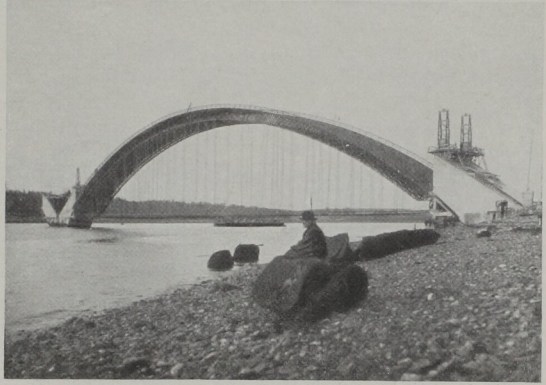
Fig. 8. Cintre mis en place pour le coulage du premier arc
