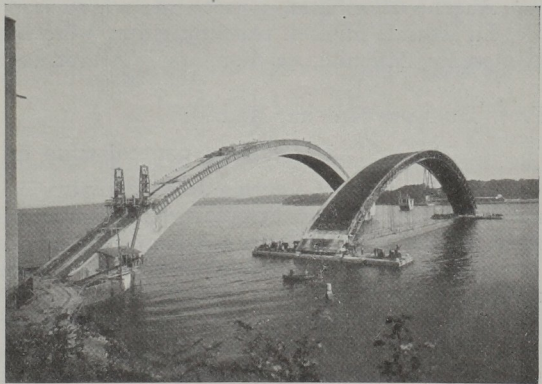
Fig. 9. Transport du cintre du premier au second arc
