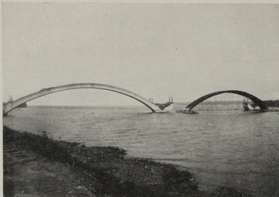
Fig. 10. Mise en place du cintre pour le coulage du 2 e arc
