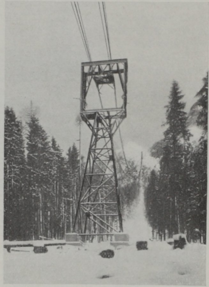
Abb. 12. Ehrwald—Zugspitze. Stütze mit Pyramidenrumpf und Portalkopf
