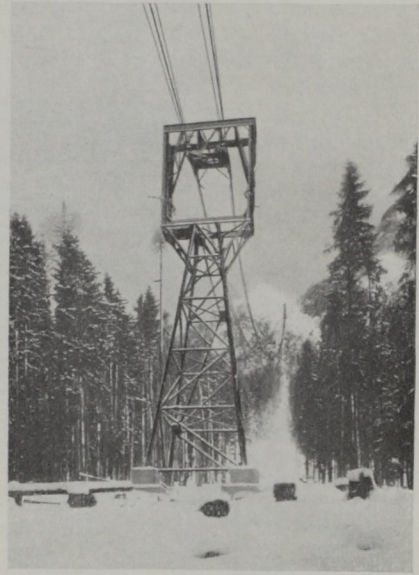
Abb. 12. Ehrwald—Zugspitze. Stütze mit Pyramidenrumpf und Portalkopf
