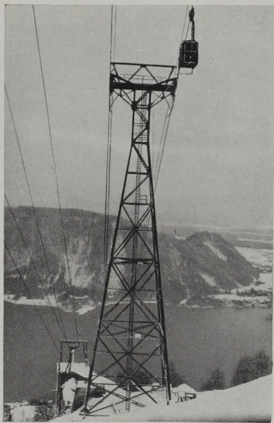
Abb. 9. 39 m hohe Stütze der Kanzelbahn am Ossiachersee
