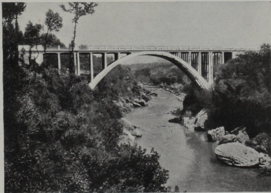
Fig. 50. Pont sur le Brembo pour l'Auto-Strada Milano-Bergamo. Arcs encastrés: ouvert. m 52,00; flèche m 14,50
