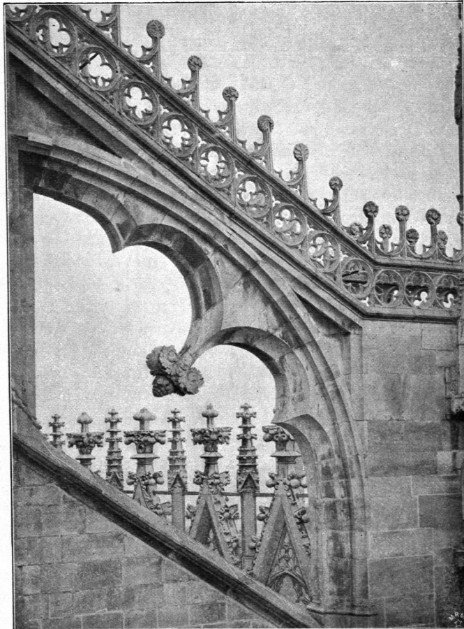
Abb. 12. Strebebogen (Detail) des Mailänder Domes.
