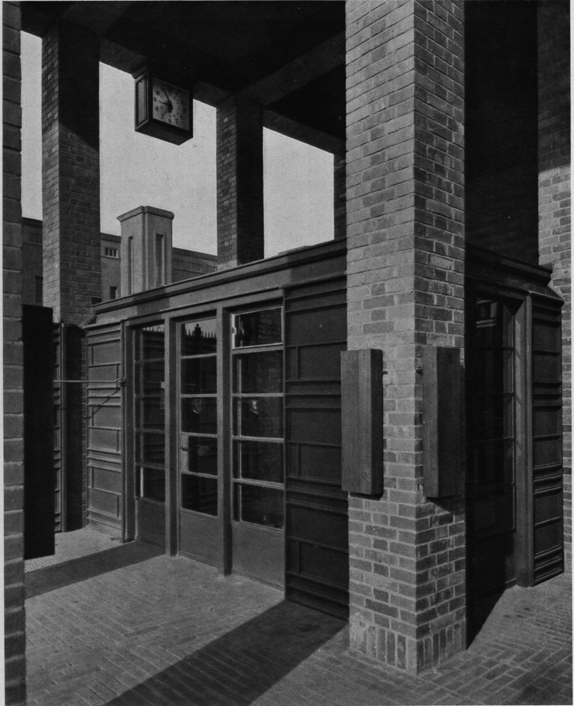
Büro- und Wohlfahrtsgebäude. Pförtnerhaus
