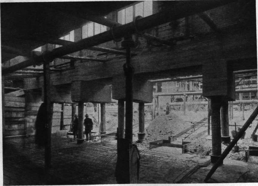
Abb. 470. Hilfskonstruktionen zum Abfangen der Frontwand der Fabrikationshalle beim Bau der Schlingenkanäle nach Abb. 469.
