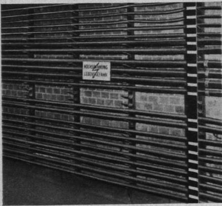
Abb. 452. Verlegung von Kabeln auf Wandregistern.
