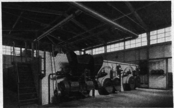
Abb. 380. Flammrohrkessel-Anlage; links ein Kessel mit Wurfffeuerung.
