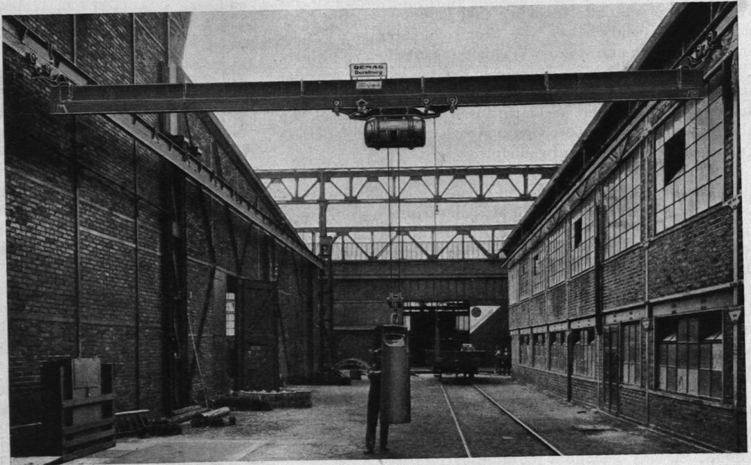
Abb. 230. Hängekran, zusammengestellt aus genormten Bauteilen.
