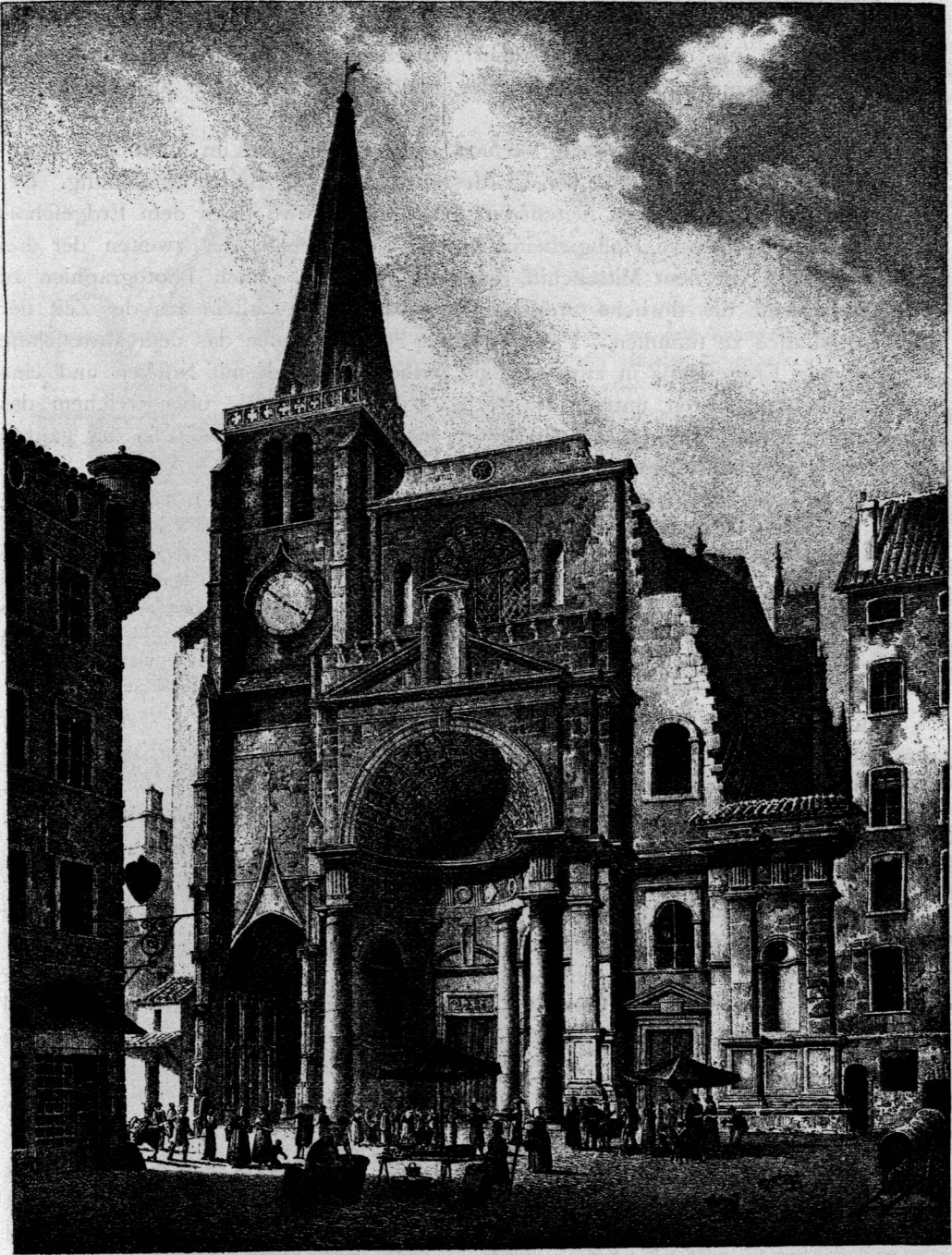
St.-Nizier zu Lyon. Ursprüngliche Façade 1011 ).
