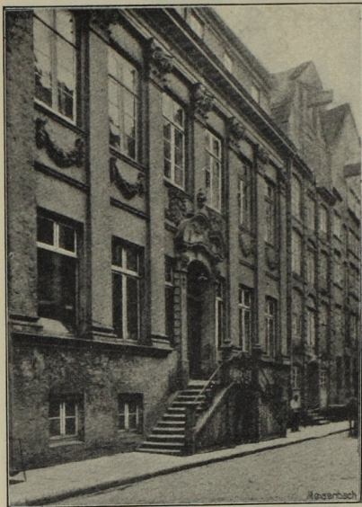
Abb. 53. Neuer Wandrahm. (Nach Hamburg und seine Bauten.)
