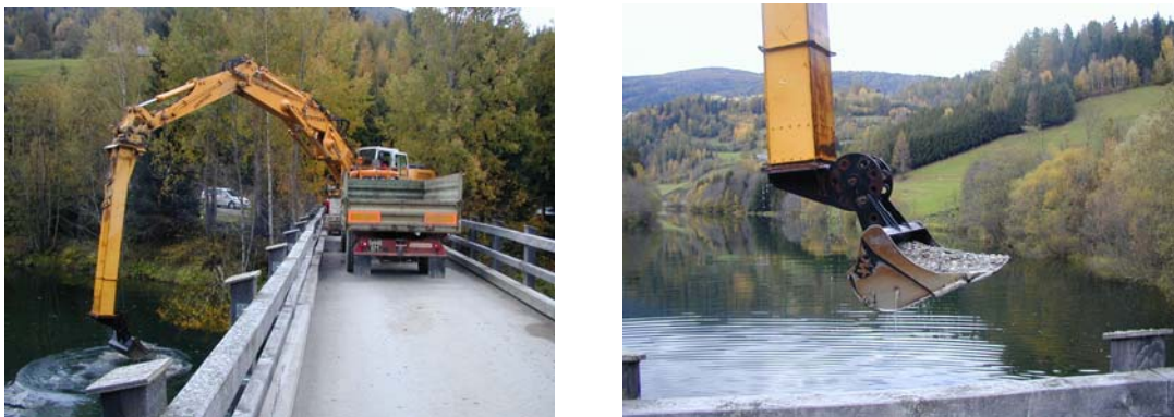
Abbildung 6: Entnahme des Sediments aus dem Stauraum
