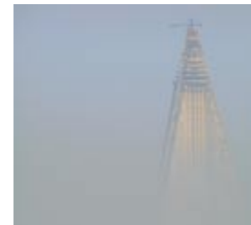
Schemenhaft taucht der Bau aus dem Nebel.
