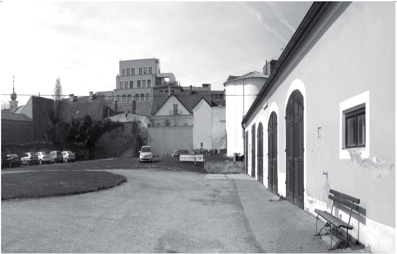
Abb. 17 Meierhof Westen, im Hintergrund die ehem. Friedhofskapelle
