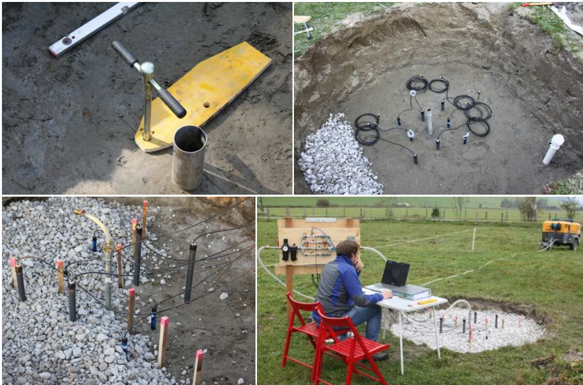
Abb. 3-15: Einbau der Messgeräte und Versuchsaufbau
