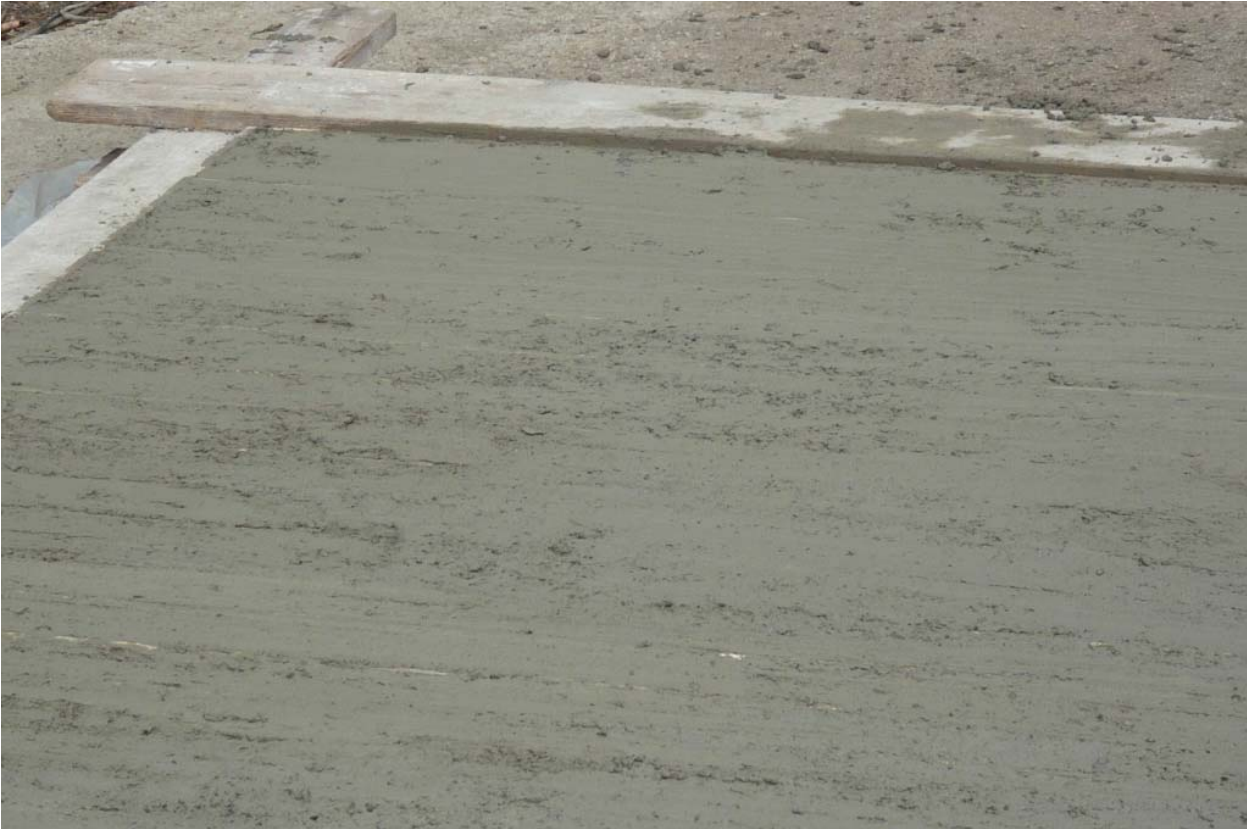
Abbildung 90. Aufnahme nach dem Betonieren
