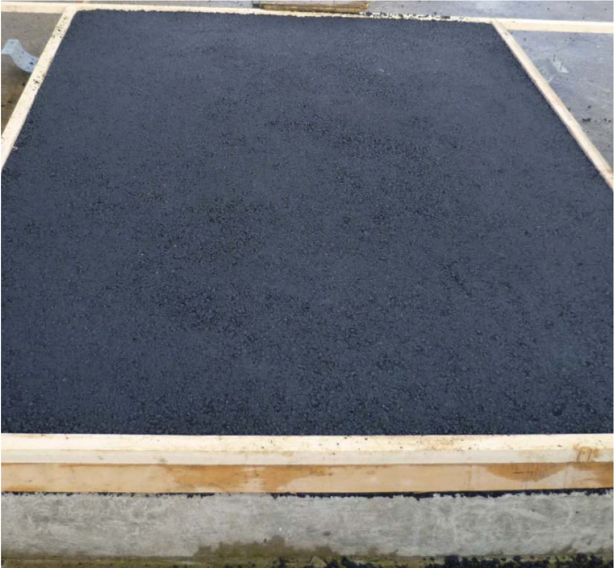
Abbildung 92. Fertiggestellte Versuchsplatte mit 8 cm AC 22 trag und 3 cm AC 11 deck
