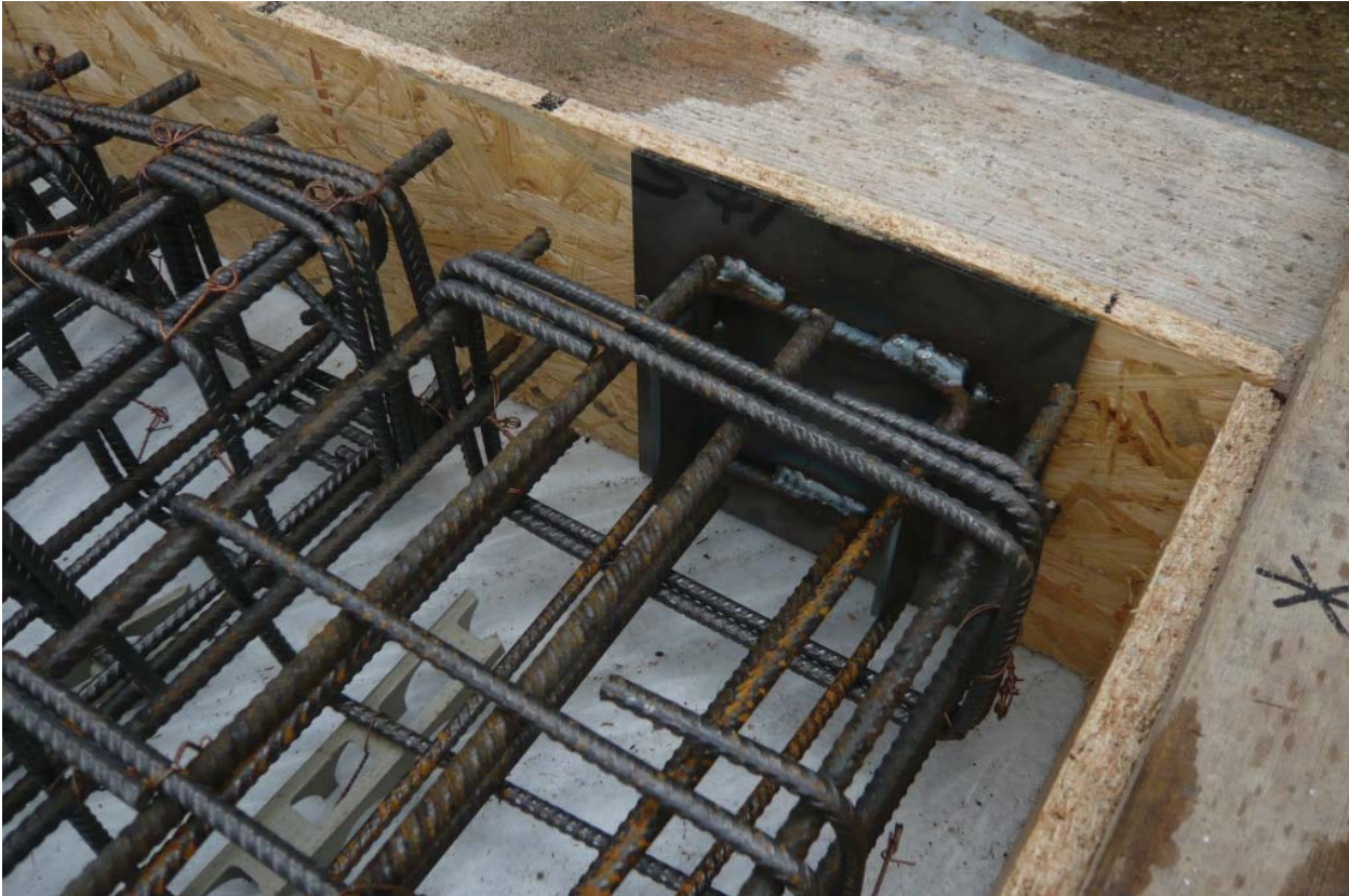
Abbildung 88. Ansicht der Stahleinbauteile für Lasteinleitung
