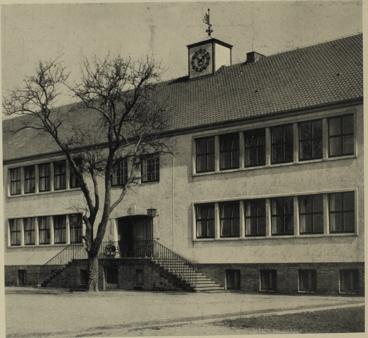
Sechzehnklassige Stadthafenschule in Essen-Vogelheim. Oben: Teilansicht des Klassengebäudes mit dem Haupteingang. Unten: Querschnitt durch das Klassengebäude mit dem Giebel der Turnhalle und dem Verbindungsbau. M. 1:600.
