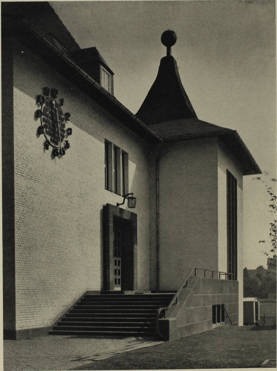
Oben: Südwestansicht des Klassengebäudes mit dem Haupteingang. Unten: Gesamtansicht von Süden. M. 1:600. Links das Turnhallengebäude, in dem am Kopfende die Hausmeisterwohnung untergebracht ist. Die äußeren Wandflächen sind in Ziegelrohbau ausgeführt und geschlämmt; Umrahmung der Eingangstüren, Freitreppe und Sockel in Basallava; Dachdeckung in grauen Handstrichpfannen.
