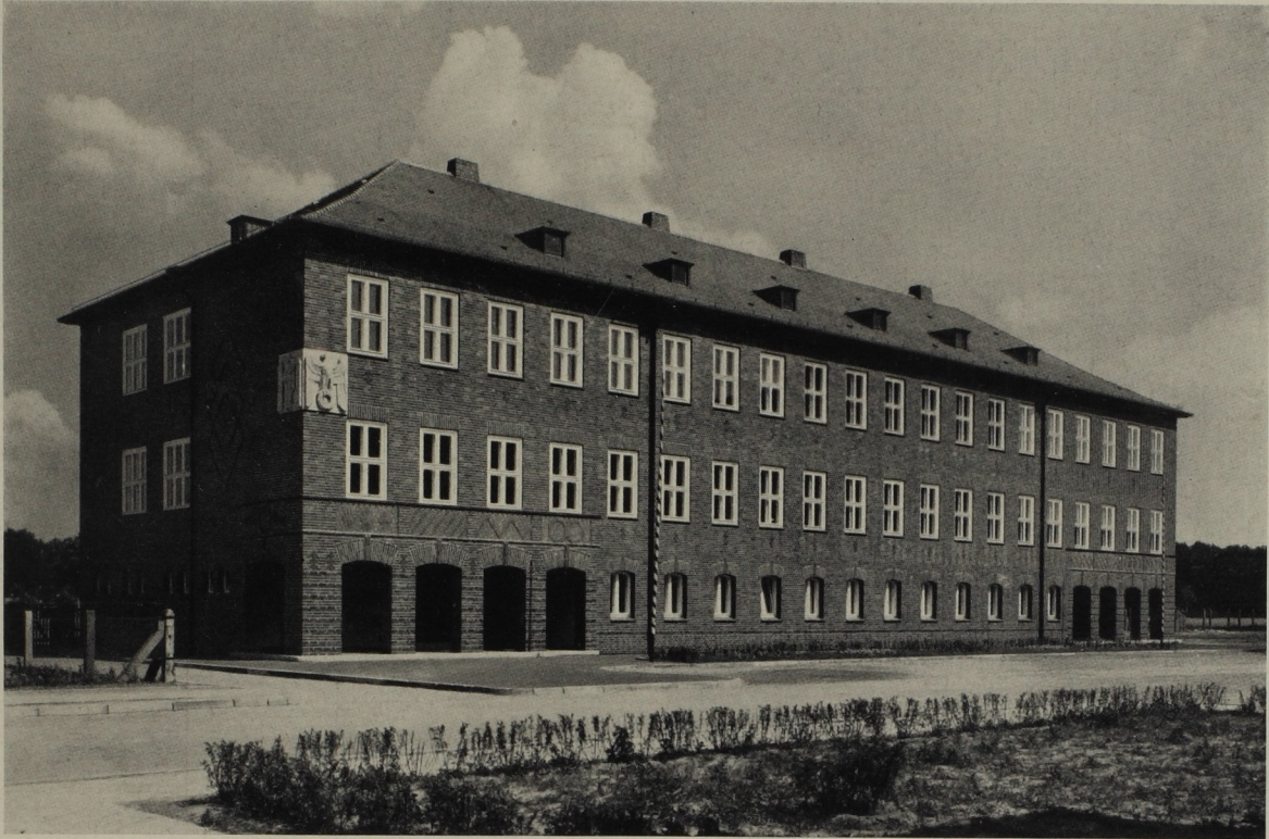
Dreizehnklassige Horst-Wessel-Schule in Guhrau, Regierungsbezirk Breslau. Architekt: Preußische Staatshochbauverwaltung. Ansicht von Westen. Außenflächen mit Klinkern verblendet; Traufgesims in Holz, 60 cm weit auskragend.
