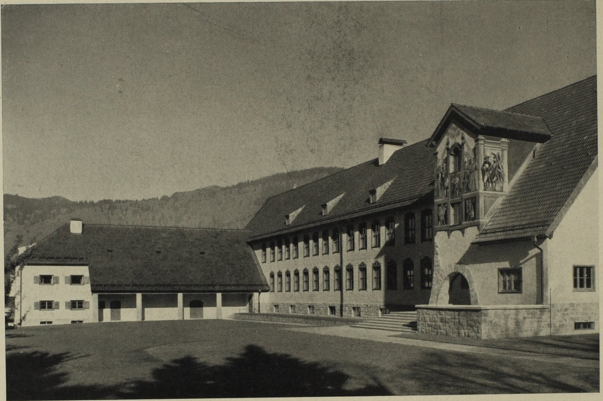
Achtklassige Schule in Oberammergau. Blick vom Kurgarten auf den Schulhof. Von links: Wohnhaus, Turnsaal, Klassenhaus und Eingangsbau. Unten: Schnitt durch das Klassenhaus und Ansicht des Turnsaal- und Wohnungsflügels. M. 1:300.
