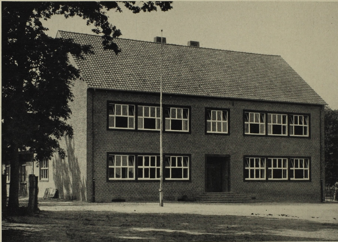
Fünfklassige Schule in Börger, Regierungsbezirk Osnabrück. Architekt: Professor Dominikus Böhm, Köln. Oben: Hauptansicht. Gruppenfenster in Eichenholzargen. Unten: Erdgeschoß und Obergeschoß. M. 1:300. Im Kellergeschoß Schulküche mit Nebengeläß, Brause- und Wannenbäder sowie Heizungsanlage.
