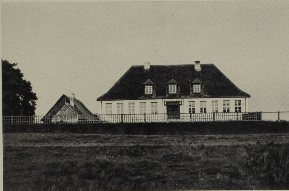
Vierklassige Schule in Groß-Peterwitz, Regierungsbezirk Marienwerder. Architekt: Preußische Staatshochbauverwaltung. Oben: Ansicht von der Straße. Unten: Grundrisse, M. 1: 500, und Lageplan, M. 1: 3500.
