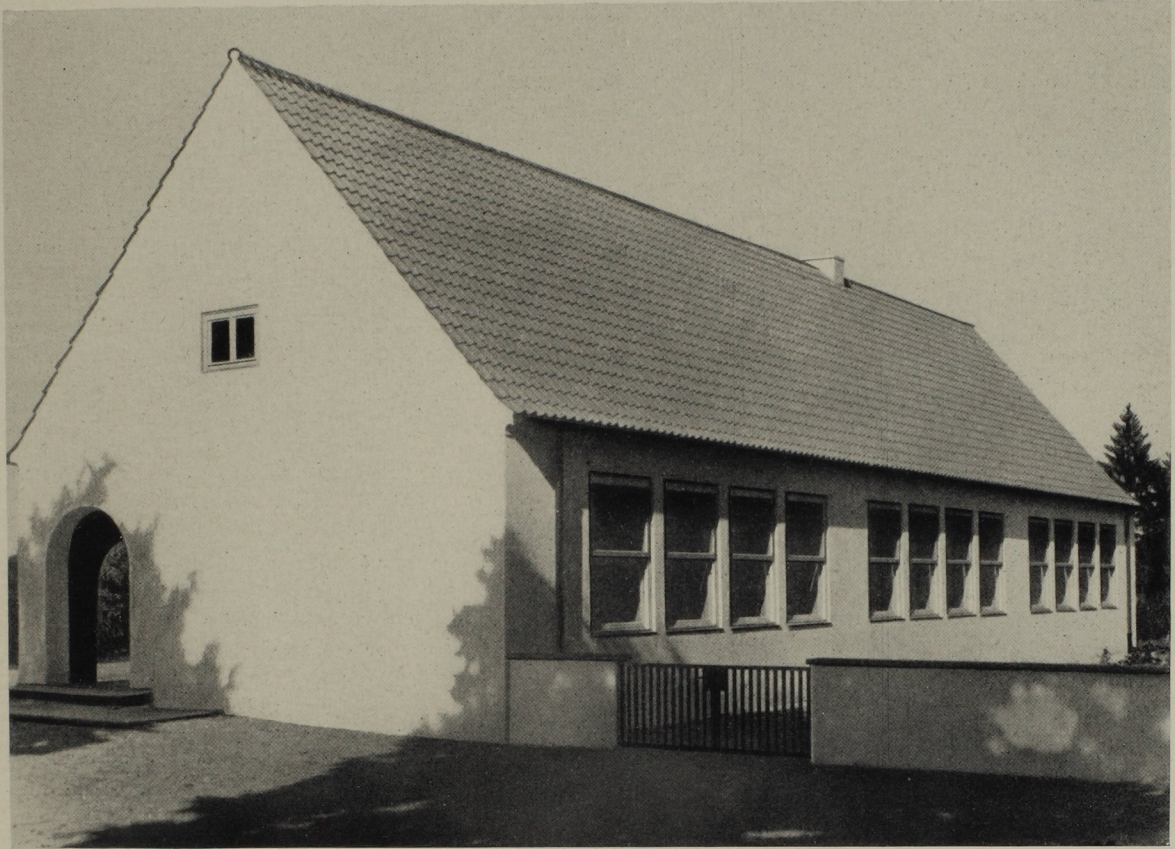
Dreiklassige Schule in Holtwick, Regierungsbezirk Münster. Architekt: Preußische Staatshochbauverwaltung. Oben: Südwestansicht. Unten: Grundriß. M. 1:300.
