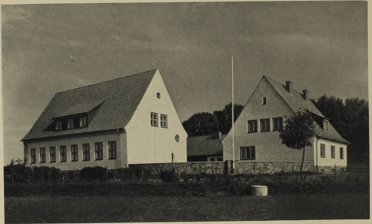
Zweiklassige Schule in Laptau, Regierungsbezirk Königsberg. Architekt: Preußische Staatshochbauverwaltung. Oben: Ansicht von Südwesten. Links das Klassengebäude, rechts das Lehrerwohnhaus, im Hintergrunde das Wirtschaftsgebäude. Sockel aus Feldsteinen; äußere Ansichtflächen in Schlechputz, mit Kalkfarbe hell gestrichen; Fenster weiß, braun und rot abgesetzt; Dachdeckung in ostpreußischen Pfannen; Holzwerk der Dachausbauten in braunem Holzton gestrichen. Fenster farbig abgesetzt. Unten: Lageplan, M. 1:2000, Grundrisse und Schnitt durch das Klassengebäude, M. 1:300.
