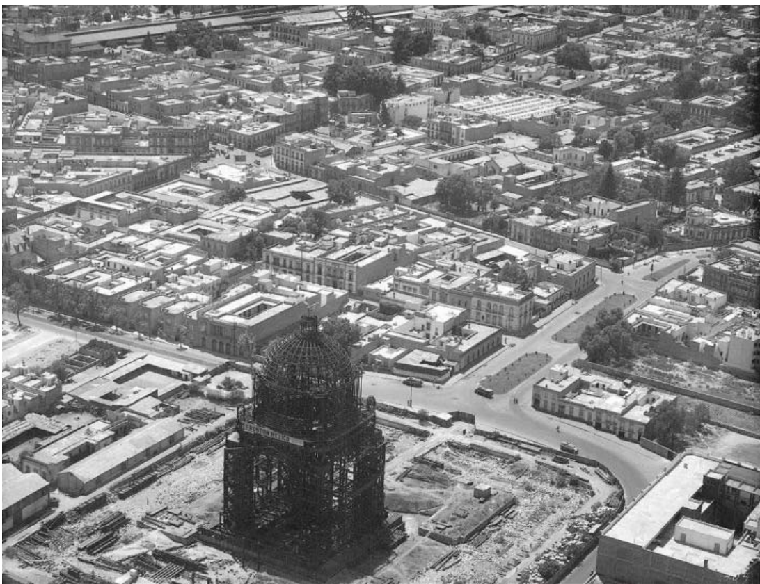
BAUSTELLE DES PARLAMENTSGBÄUDES, CA 1930
