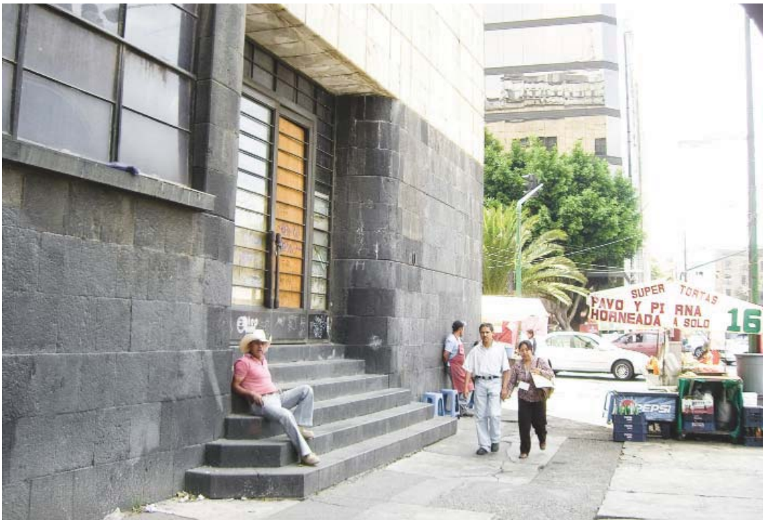
GEBÄUDEAUSSTEIFUNGEN | BASALTSOCKEL BESTANDSFASSADE
