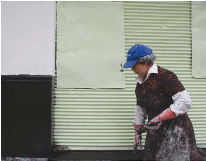
2 FRAU BEIM STREICHEN DER FASSADE
