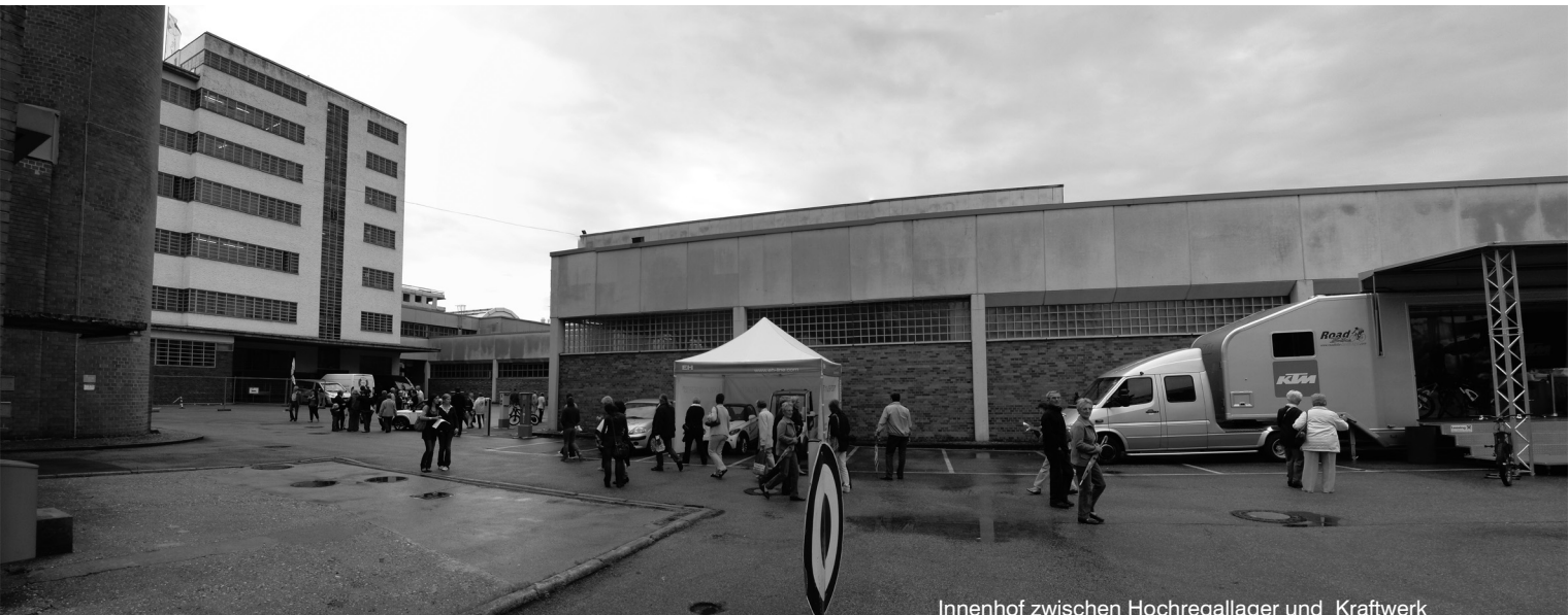
Innenhof zwischen Hochregallager und Kraftwerk
