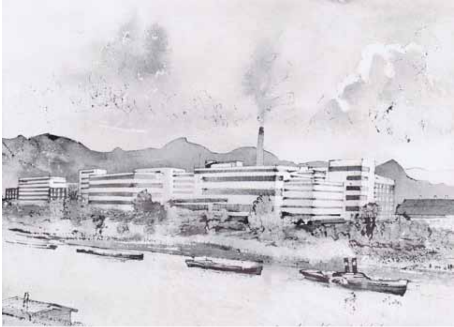
Bild 07 - Die Neubauten der Tabakfabrik, Aquarell E.A. Mandelsloh
