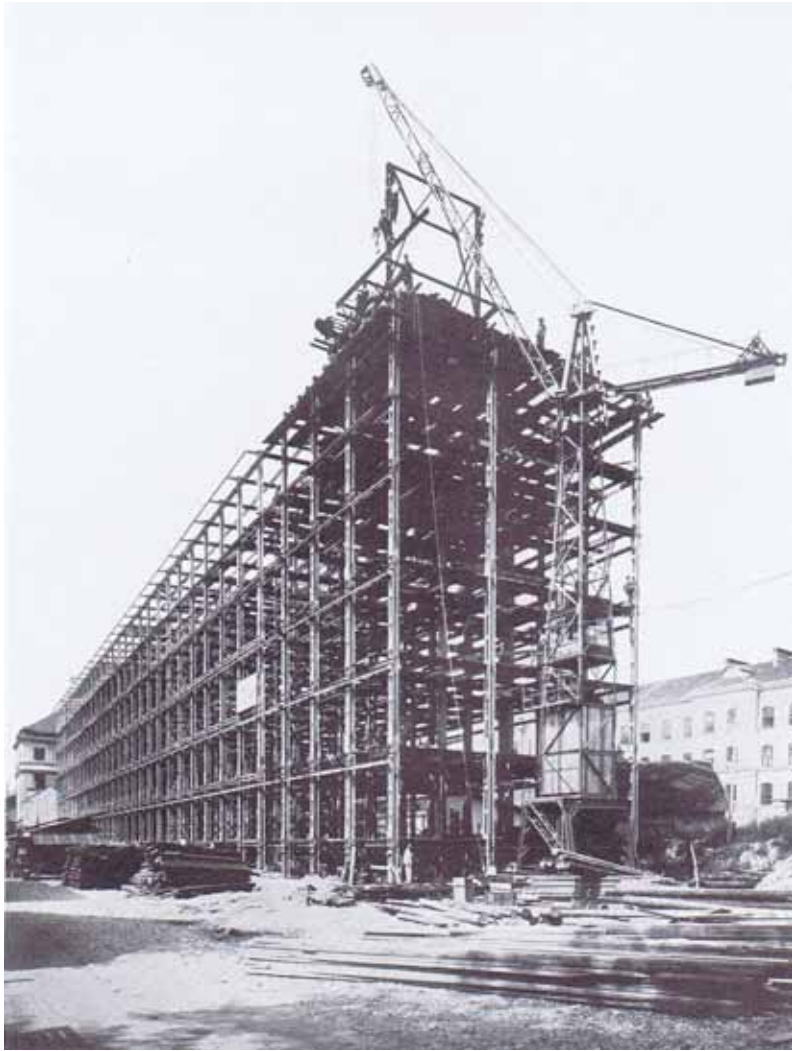
Bild 13 - Das Stahlskelett der Zigarrenfabrik
