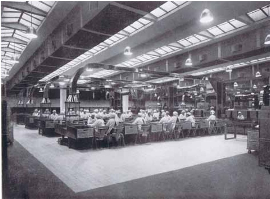
Bild 10 - Lösehall, Misch- und Sortieranlage
