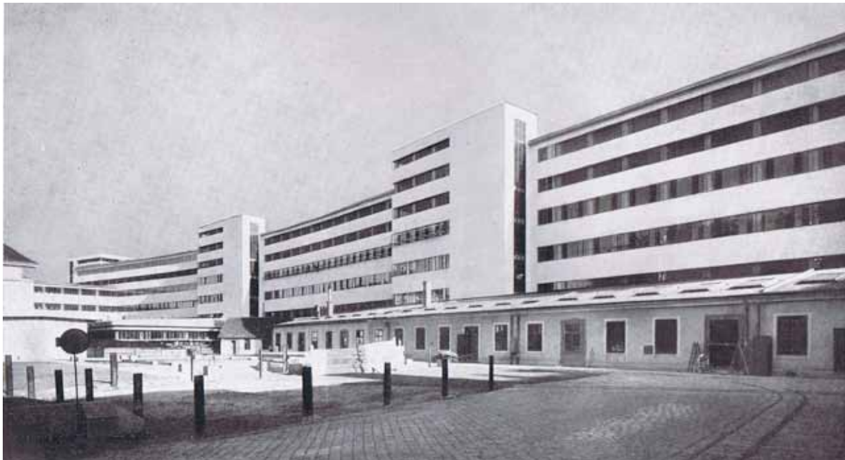
Bild 08 - Zigarettenfabrik hofseitige Ansicht
