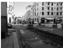
2 + 3 Die Strassenbahn in Rabat ist bereits fertiggestellt, in Casablanca befindet sie sich gerade in Bau.
