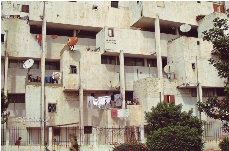
12 + 13 Aktuelle Fassade des Wohnbaus Nid d'abeille Casamemmoire- Dans le désert de la modernité, Oktober 2009.
