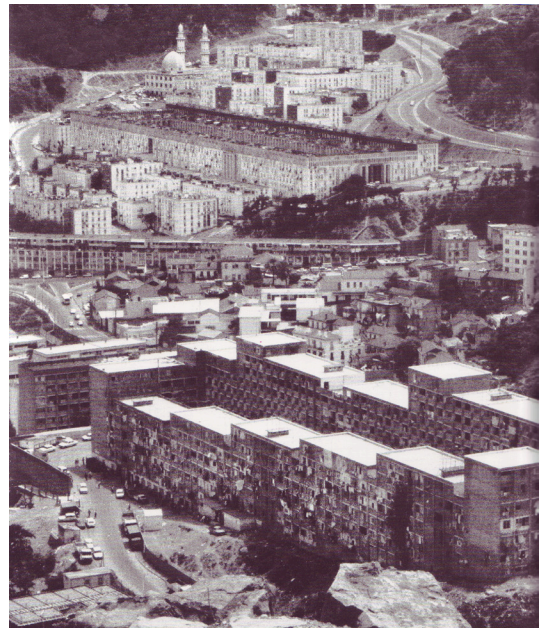
3 Großwohnbauten in Algier: im Vordergrund Carrière Jaubert by Simounet, Daure, und Béri, im Hintergrund Climate de France von Pouillon
