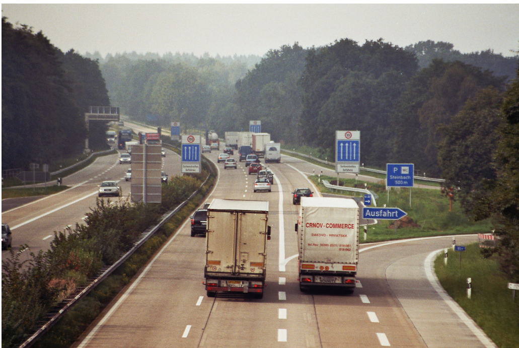
Abbildung 5-3: Anschlussstelle in Niedersachsen (BAB A7) mit durchlaufendem Seitenstreifen
