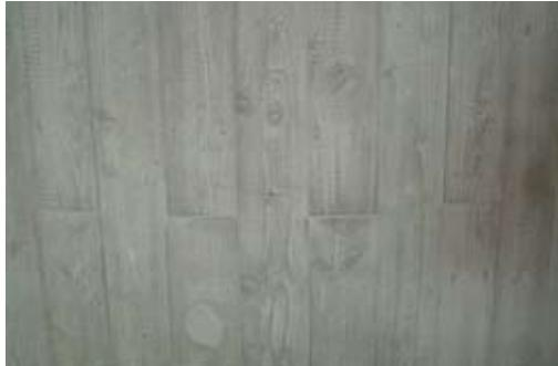
Abb. 188 Oberfläche Sichtbeton
