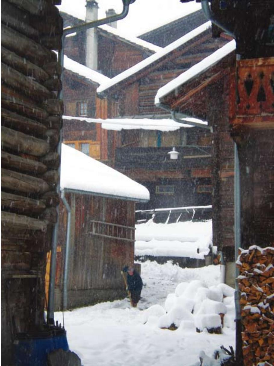
Abb. 181 Additive Bauweise
