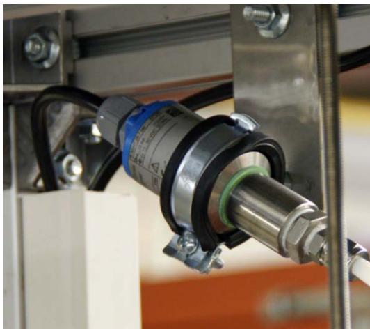
ABBILDUNG 6-28: ABSOLUTDRUCKSENSOR
