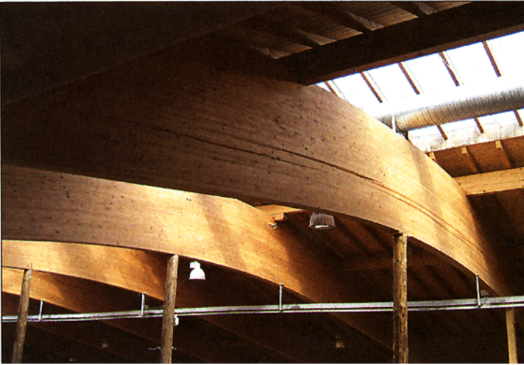
Abb. 1.1 Typischer Querschnitt eines gekrümmten BSH-Bauteiles [24]
