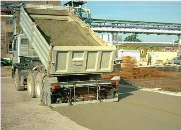
Bild 2.21 Betoneinbau durch Schütten<sup>42</sup>
