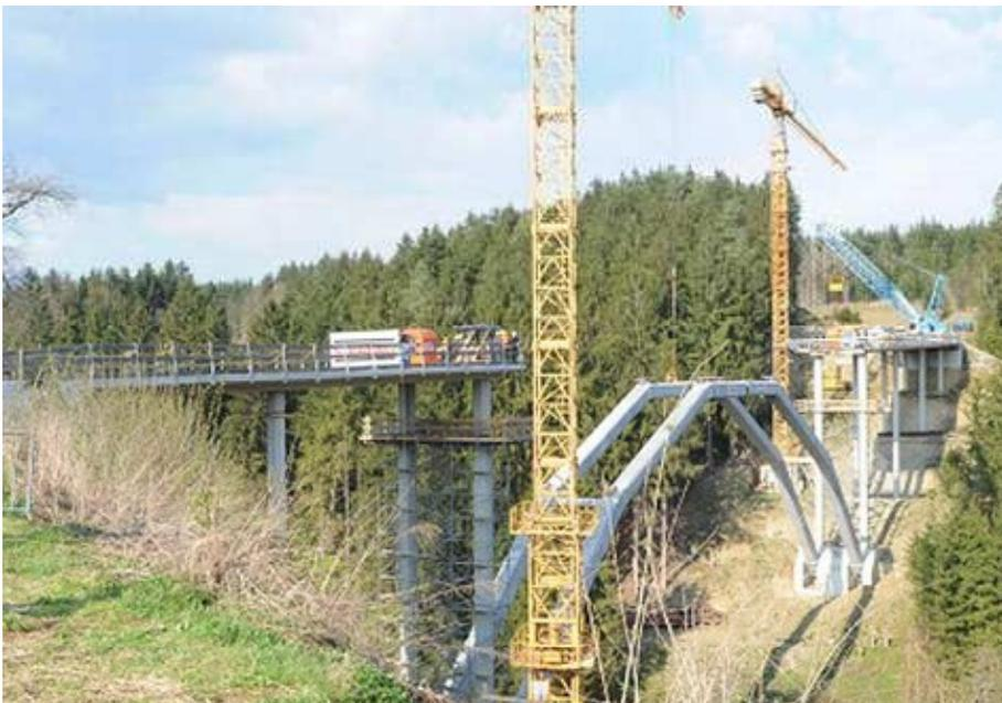
Bild 2.5 Wild-Brücke bei Völkermarkt, Ultra High Performance Fibre Reinforced Concrete (UHPFRC)
