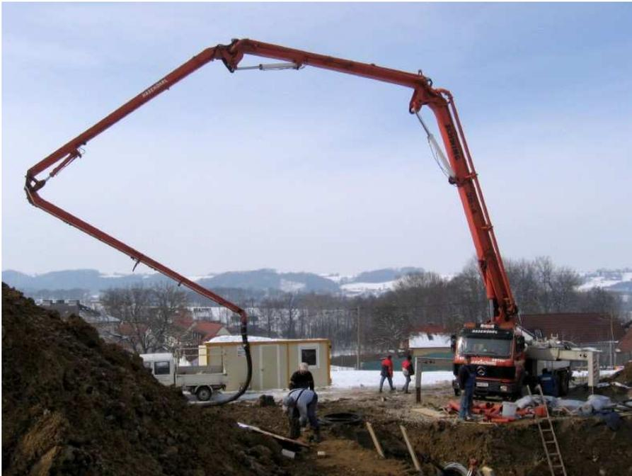
Bild 2.23 Betoneinbau mittels mobilem Ausleger<sup>43</sup>
