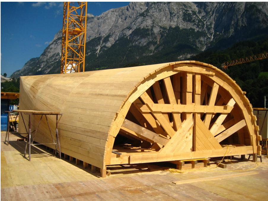
Bild 2.10 Konventionelle Schalung für den Bau des Einlaufbauwerks Kraftwerk Werfen/ Pfarrwerfen
