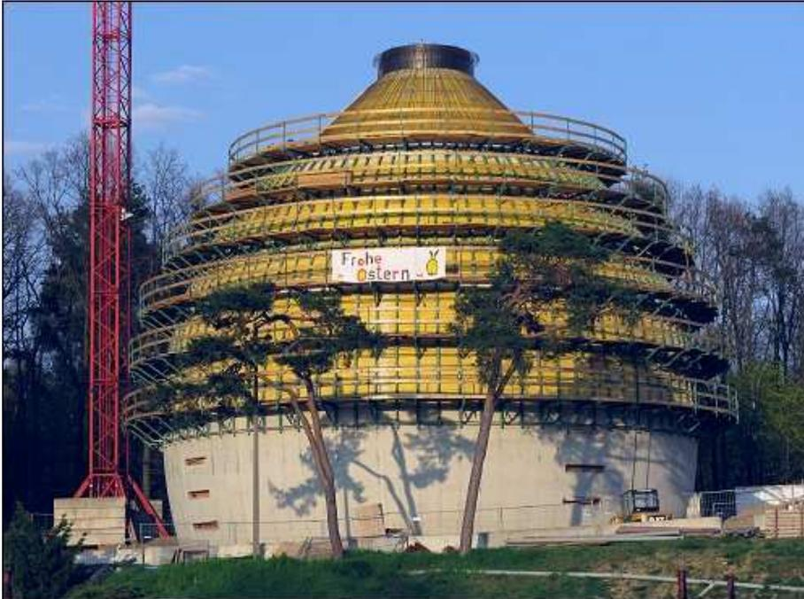
Bild 2.16 Sonderschalungen beim Bau von Faulbehältern <sup>33</sup>
