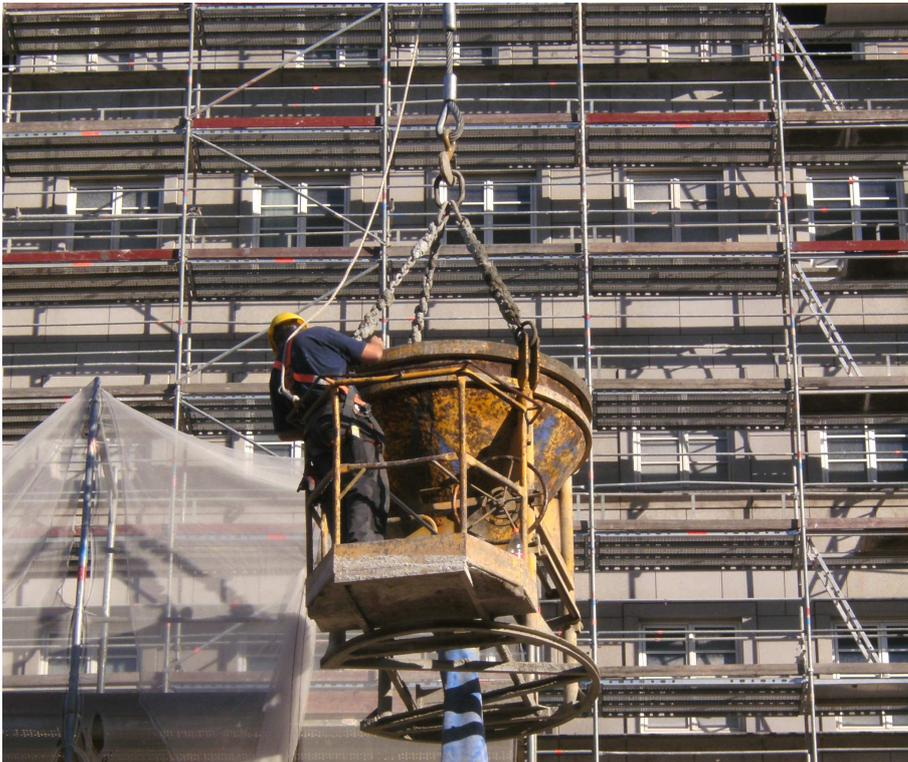
Bild 2.22 Betoneinbau mittels Krankübel, Stuttgart
