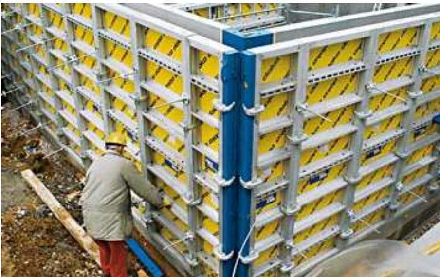
Bild 2.11 Elemente der Rahmenschalung<sup>29</sup>
