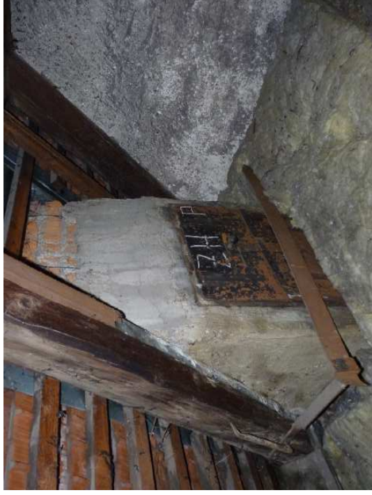
Abb 124 Kamin im Dach
