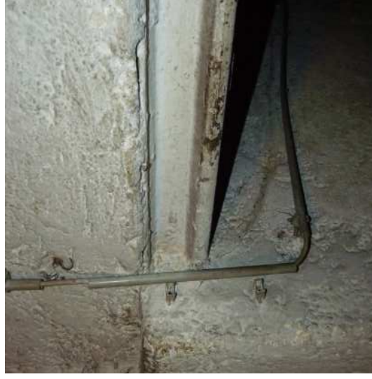
Abb 162 Eisenbahnschiene als Träger
