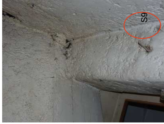
Abb 161 gerader Überzug über der Türöffnung
