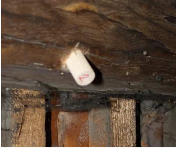
Abb 84 Bohrungen werden bezeich- net und mit einem Holzdübel wieder verschlossen
