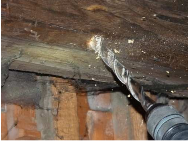
Abb 82 Bohrung mit Holzbohrer
