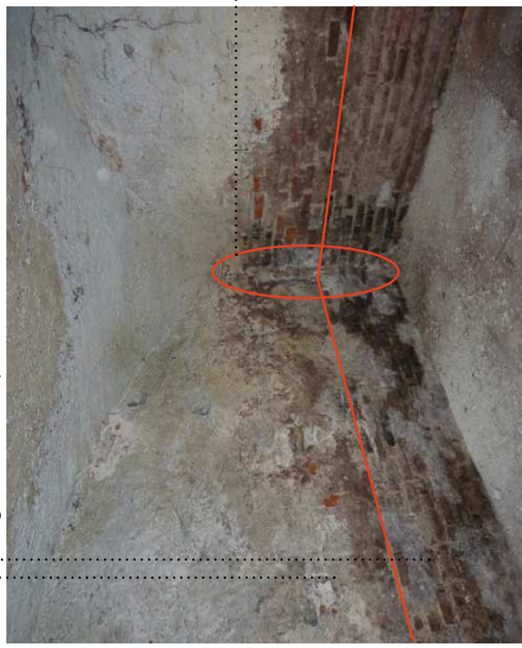
Abb 38 südliche und westliche Mauer
