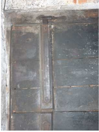
Abb 146 Langband auf Querholz
