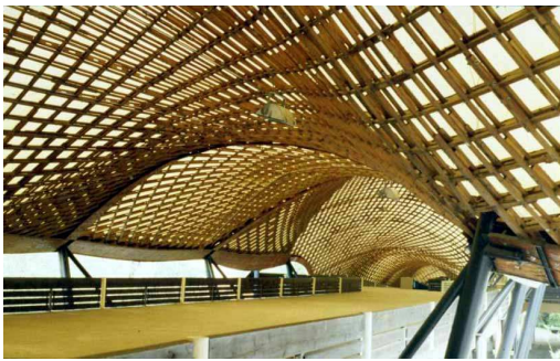
Abb. 2-3: Multihalle Mannheim , Spannweite bis 60 m, Höhe 20 m, 7.400 m 2
