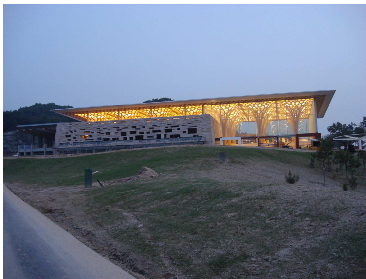
Abb. 4-31: Glasfront mit durchscheinender Holzkonstruktion
