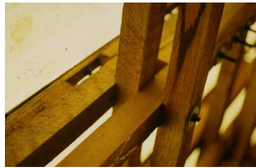
Abb. 2-4: Multihalle Mannheim, Vollholz-Latten 50/50 mm, 2-lagig
