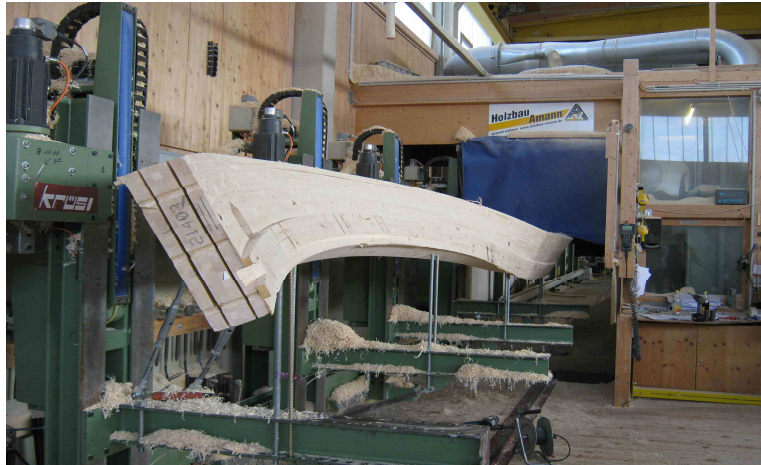
Abb. 4-9: Schlitz für die Montage der Stahlbleche
