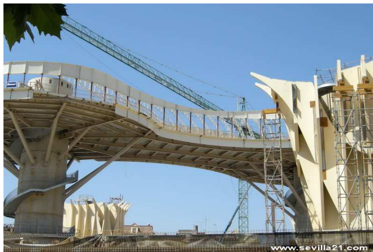
Abb. 4-44: Stahlbetontürme mit den Nottreppen
