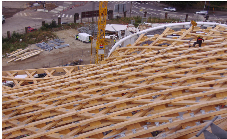
Abb. 4-8: Balkenlage mit Furnierschichtholz-Nocken und Scherblöcken
