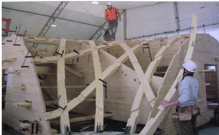
Abb. 4-29: Aufbau der Trägersegmente mit Hilfe von CNC-gefertigten Schablonen
