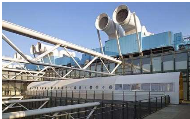
Abb. 4-4: Büro Shigeru Ban im 6. Stock des Centre Pompidou in Paris
