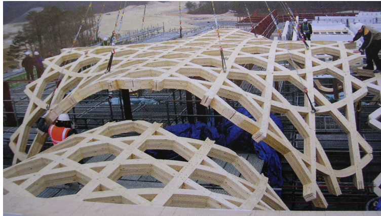
Abb. 4-30: Versetzen eines Dachelementes
