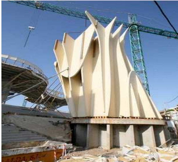
Abb. 4-48: Abstützungen während der Montage
