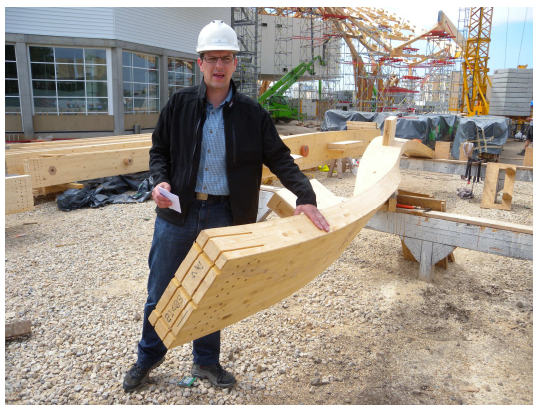
Abb. 3-16: Mehrfach gekrümmter Bauteil
