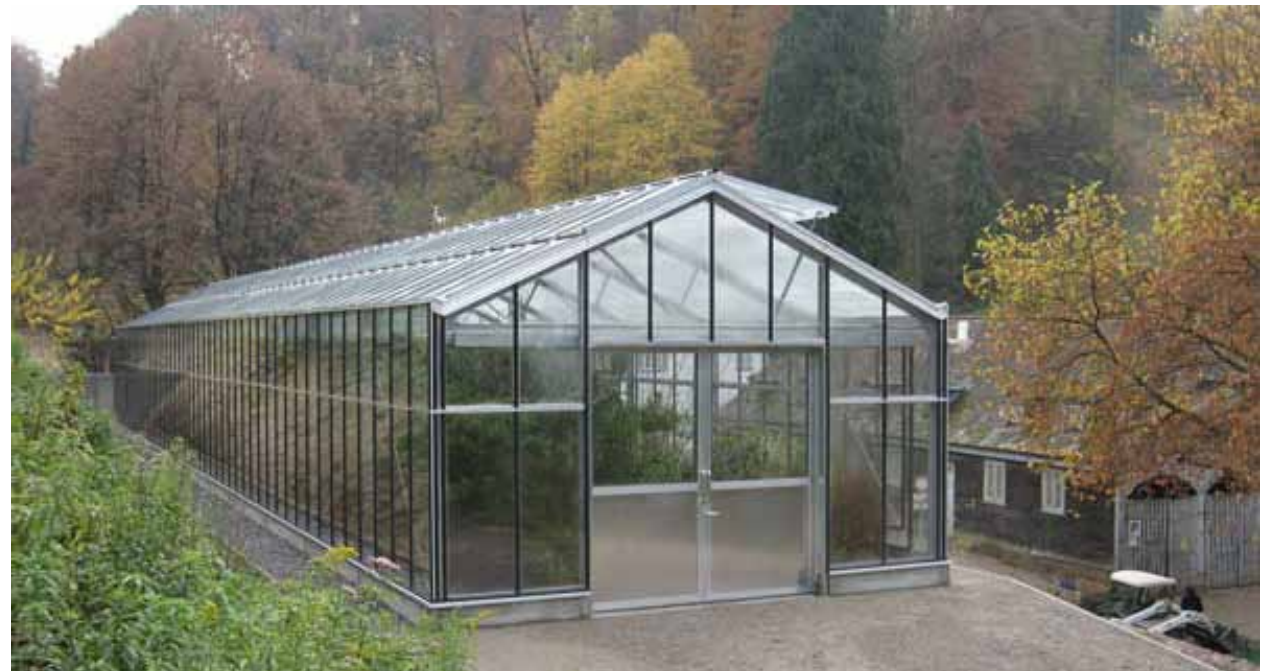
Abb.66 Gewächshaus mit Stahlgerüst und Isolierverglasung
