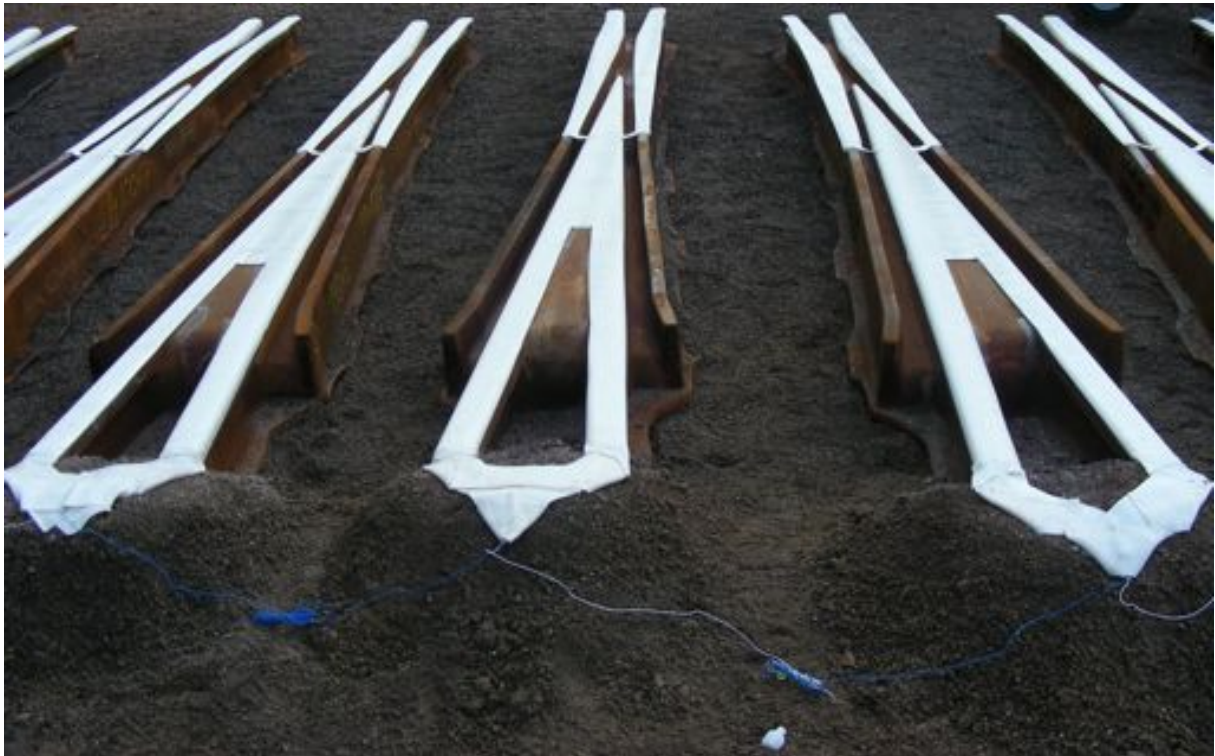
Abbildung 3.27: Auftrag der Explosionsschicht [1]
