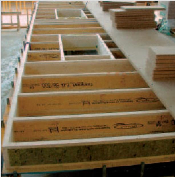
Abb. 203: Elementwechsel - Dachoberlicht
