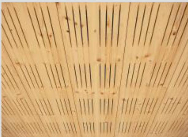
Abb. 204: Akustikprofilierung Deckenunterseite
