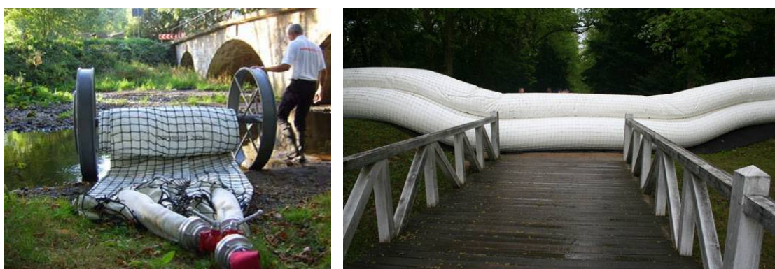
Abb. 88 Wasserbefülltes Schlauchsystem [99]
