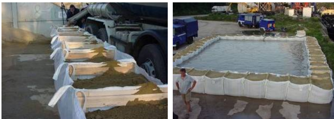
Abb. 129 Offenes Behältersystem [149]
