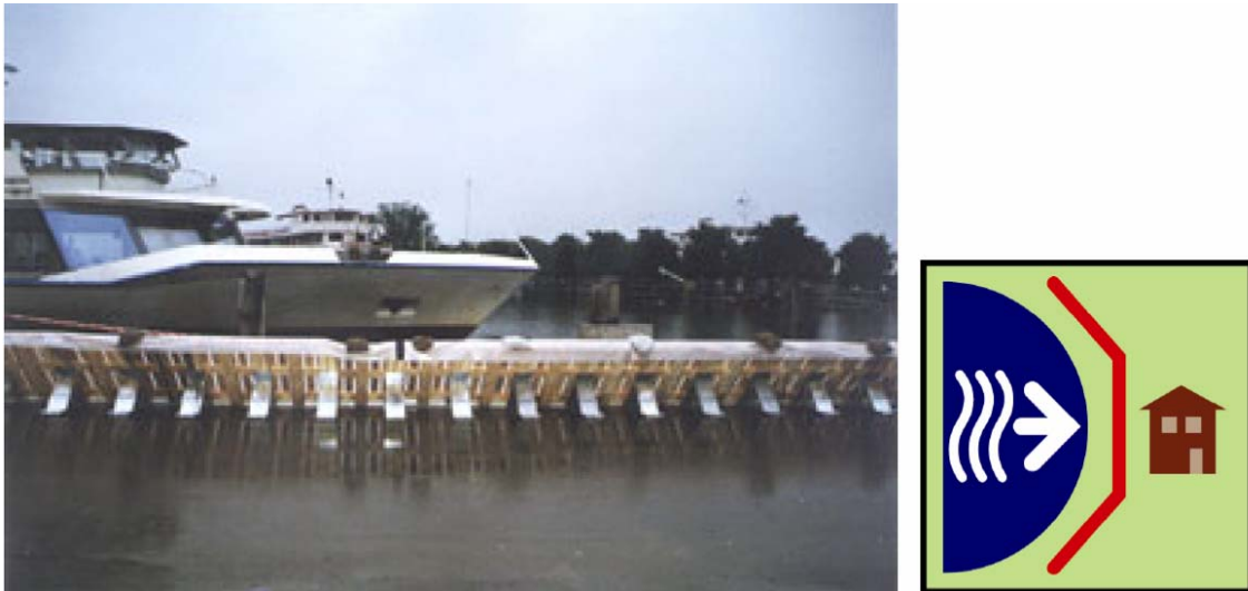
Abb. 152 Linienschutz bei großen Flächengewässern Seen [174]
