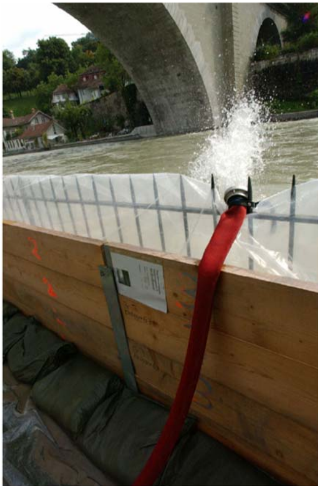
Abb. 153 Linienschutz bei Fließgewässern mit einem geringen bis mittleren Gefälle [175]
