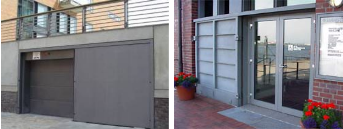
Abb. 65 Schiebetorsysteme: links [75], rechts [76]
