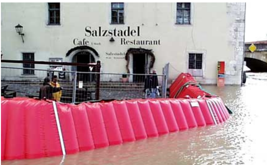
Abb. 136 Geschlossenes Behältersystem im Hochwassereinsatz [157]
