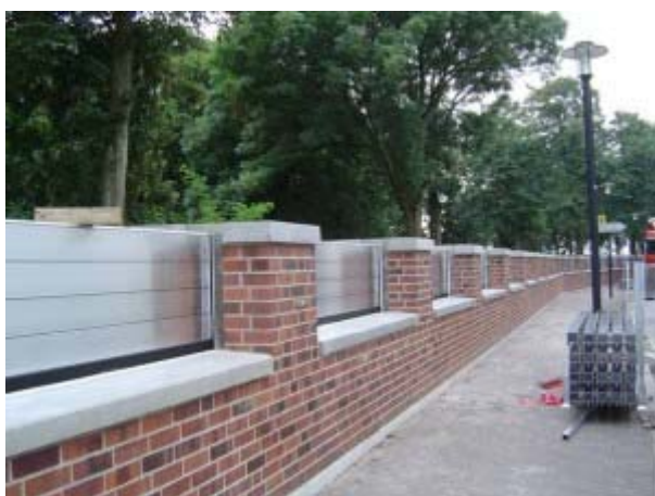
Abb. 53 Dammbalkensystem [62]
