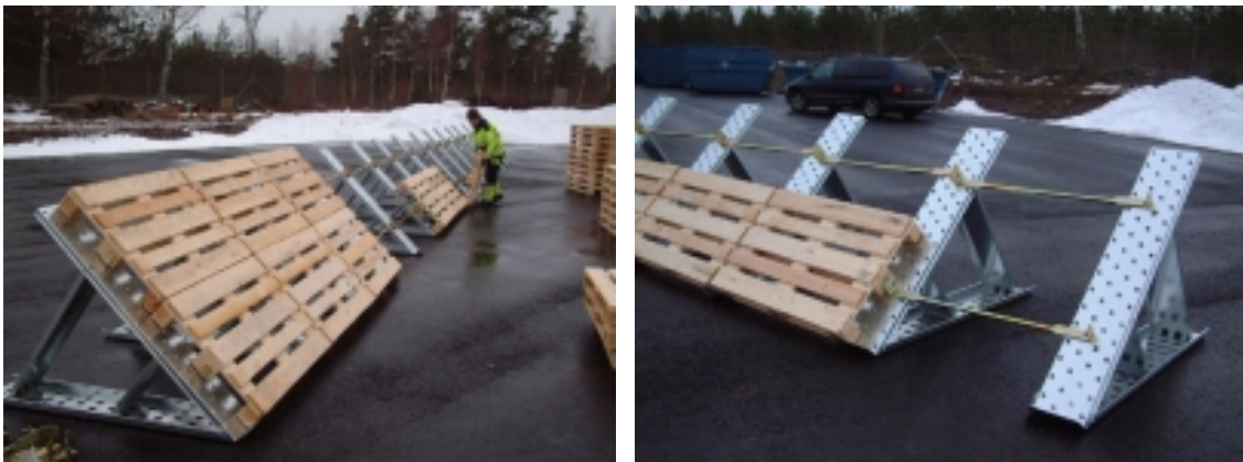
Abb. 120 Stellwandensystem mit Europaletten [140]
