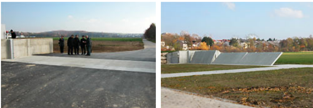
Abb. 77 Hochwasserrückhaltebecken in Form einer Klappwand [88]
