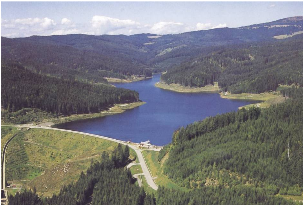
Abb. 23 Speicher Soboth, Österreich [28]
