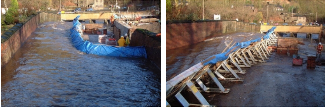
Abb. 121 Stellwandsystem mit Europaletten im Einsatzfall [141]
