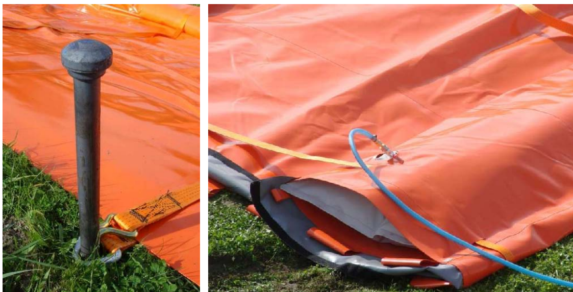
Abb. 86 Befestigung und Befüllung eines Schlauchsystems (Luftbefüllung) [97]
