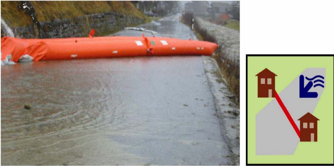
Abb. 151 Sperren von Abflüssen auf Straßen [173]
