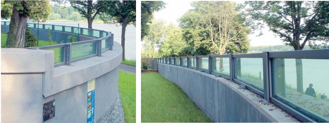
Abb. 91 Aufstockung einer Schwergewichtsmauer mit 40 cm Glaswandsystem in Köln Westhoven am Rhein um das geforderte Schutzziel zu erreichen [102]
