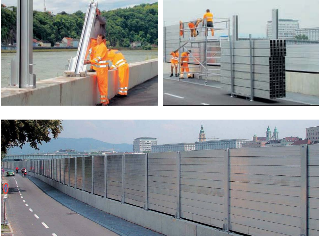
Abb. 55 Aufbau eines Dammbalkensystems in Linz [64]
