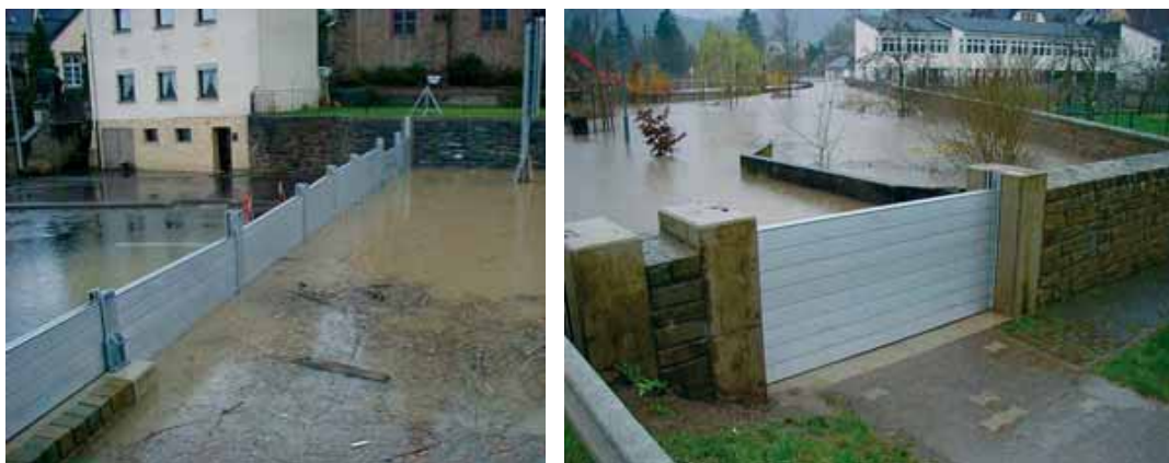
Abb. 52 Dammbalkensystem im Hochwasserfall [61]
