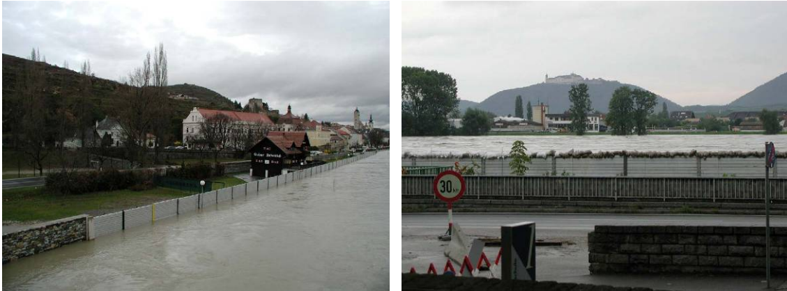
Abb. 177 Mobiler Hochwasserschutz Krems - Stein im Einsatzfall [205]
