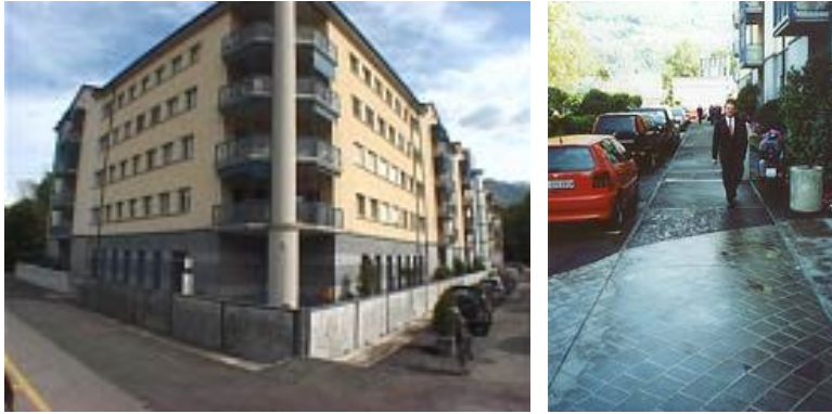
Abb. 76 Klappwand im Einsatz und in Normalposition, Oberfläche ist der Umgebung angepasst [87]
