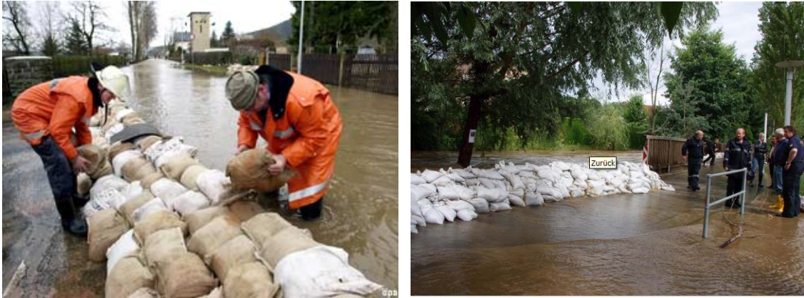
Abb. 116 Aufbau eines Sandsackwall [135], Graz – Andritz [136]
