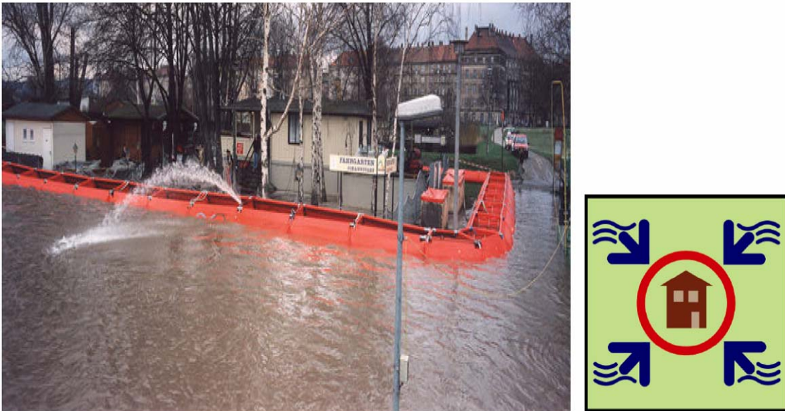
Abb. 150 Ringschutz bei einer Muldenlage [172]
