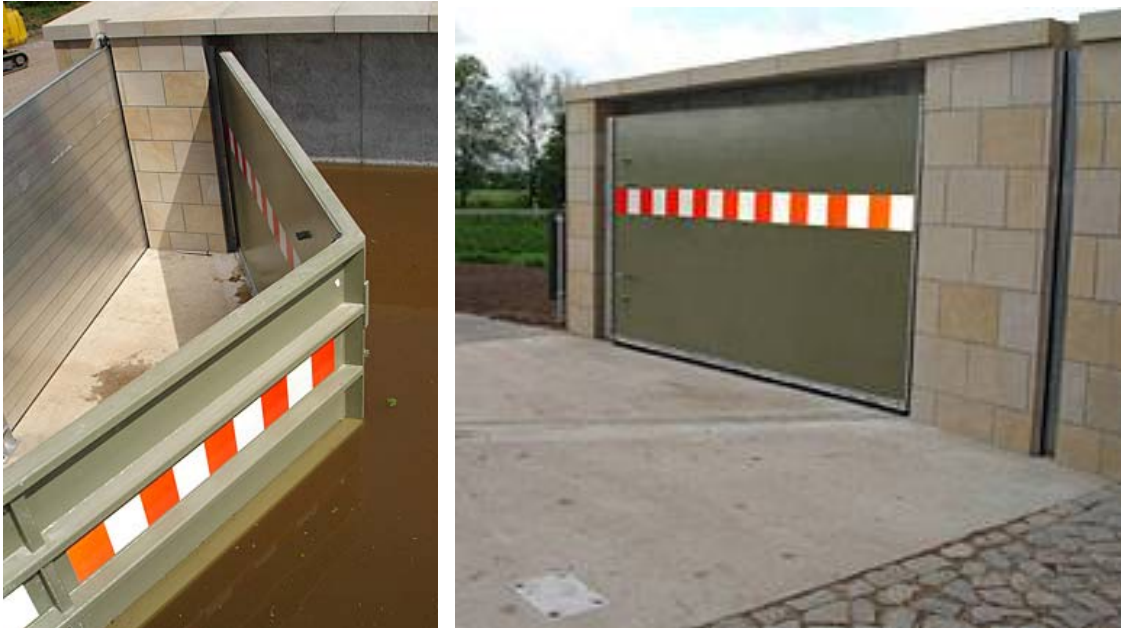
Abb. 69 Stemmtor im geschlossenen und geöffneten Zustand [80]
