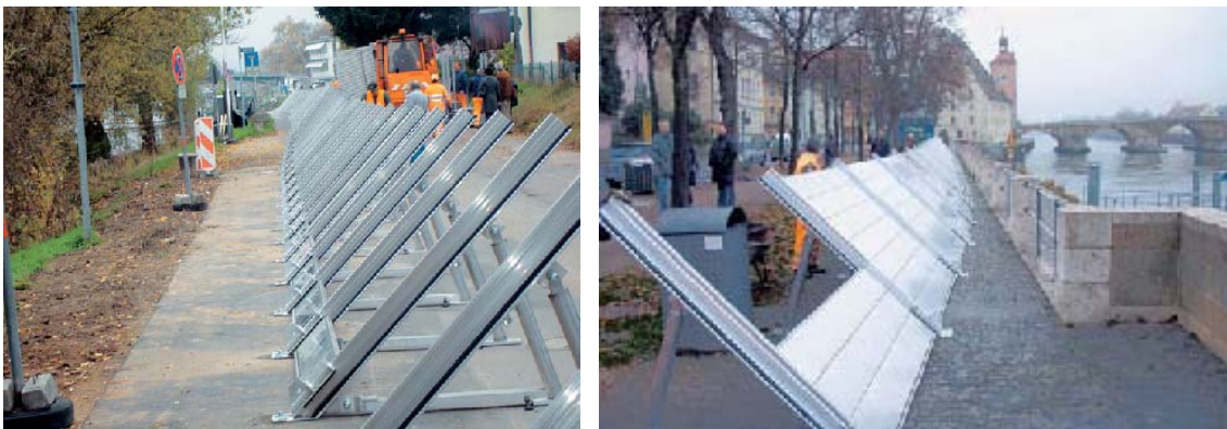
Abb. 123 Stellwandsystem mit Dammbalken, keine Dichtfolie erforderlich [143]
