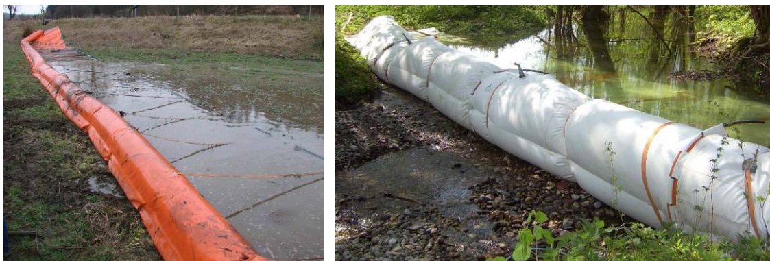
Abb. 87 Einsatzbilder eines luftbefüllten Schlauchsystems [98]
