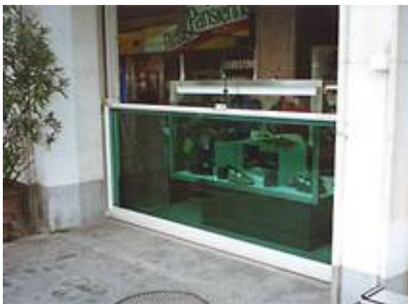
Abb. 72 Senktor aus Verbundglasplatte [83]
