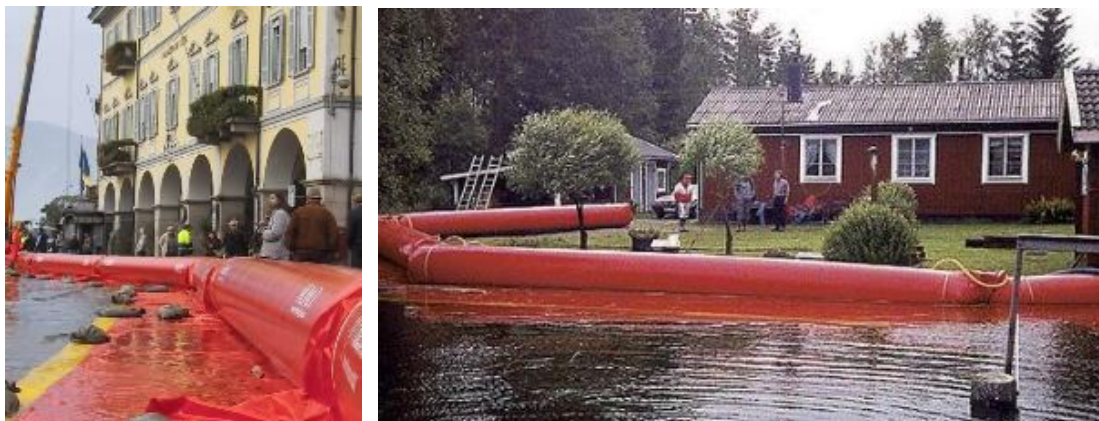
Abb. 132 Geschlossenes Behältersystem, schlauchförmig [153]
