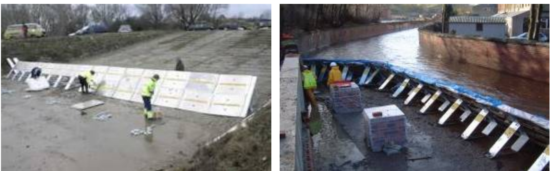
Abb. 124 Stellwandsystem mit Metalltafeln, Dichtfolie erforderlich [144]
