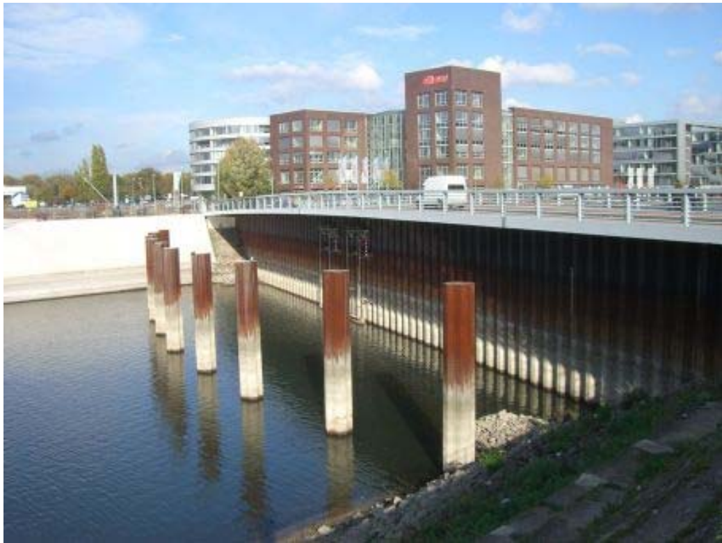
Abb. 48 Dalbenreihe als Schutz vor Schiffsanprall [57]
