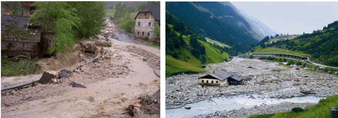
Abb. 9 Auswirkungen einer Mure links [10], rechts [11]
