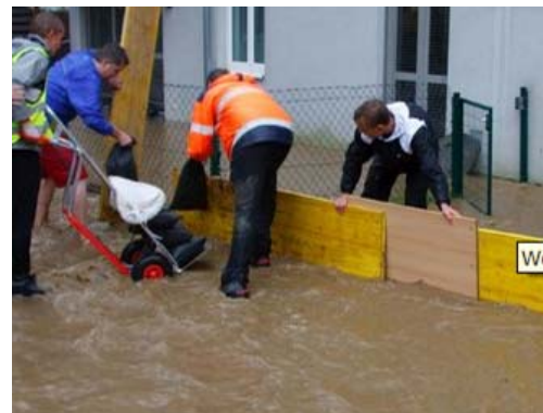
Abb. 113 Systemskizze Schalungsbretter mit Armierungseisen gehalten [130], Einsatz von Schalungsbretter gesichert mit Sandsäcken [131]
