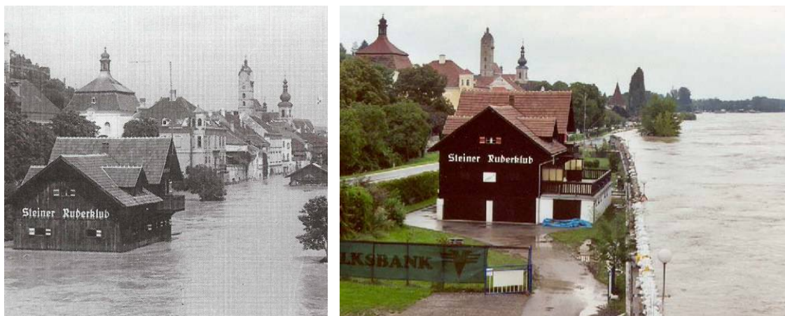
Abb. 173 Hochwasser 1954 und nach dem Ausbau auf ein HQ_{100} [200]
