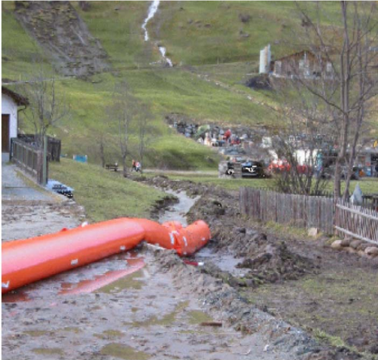
Abb. 149 Strömungsumlenkung bzw. Ableiten des Hochwassers [171]
