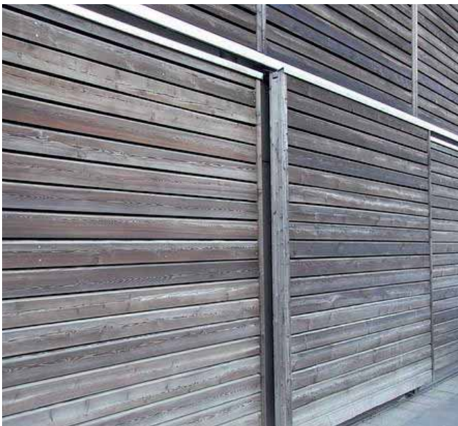
8 Holzfassade mit Schiebetüre
