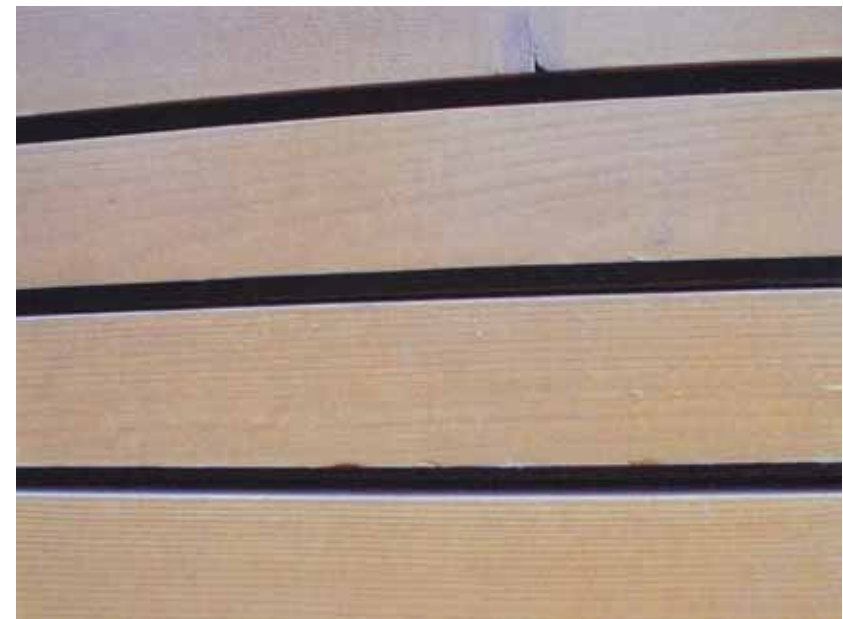
7 Brettfassade mit offenen Fugen
