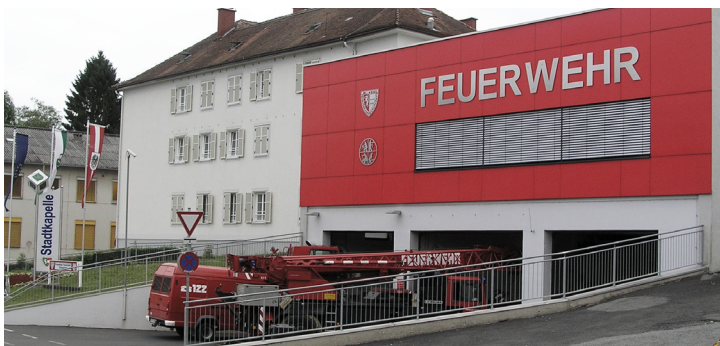
ABB.: FEUERWEHRHAUS DER FF FÜRSTENFELD
