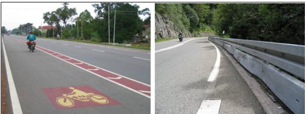
Abbildung 11 Beispiele zur Verbesserung der Sicherheit von Zweiradfahrern [10]
