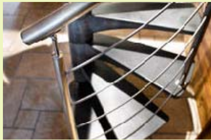
Abbildung 67: Ausschnitt einer Wendeltreppe aus UHFB (Ductal®)
