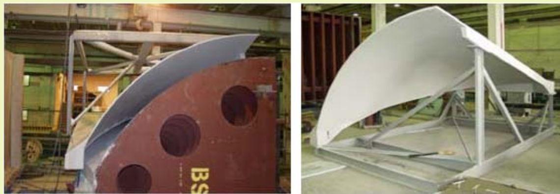
Abbildung 63: Schalungsprozess einer Halbschale 2
