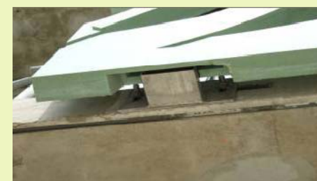
Abbildung 74: Befestigung eines Fassadenelements
