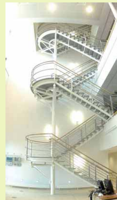
Abbildung 64: Treppenkonstruktion aus UHFB (Ductal®)/Birmingham/England
