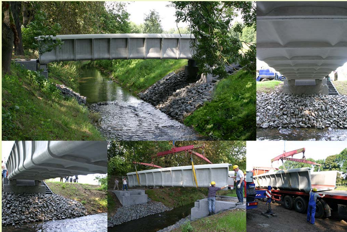
Abbildung 17: Transport und Aufbau der Textilbetonbrücke in Oschatz
