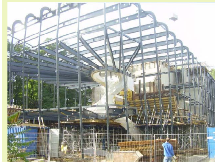
Abbildung 94: Bau des Twists - Radial verlaufende I-Träger
