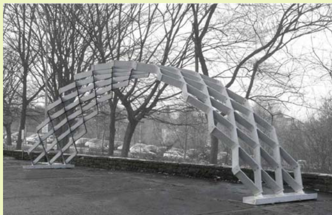
Abbildung 34: Prototyp des Rautenfachwerks aus Textilbeton
