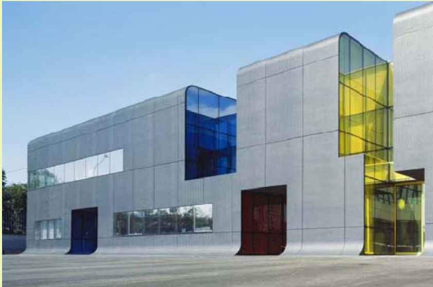
Abbildung 75: Verwaltungsgebäude und Busgarage der RATP in Thiais/Paris
