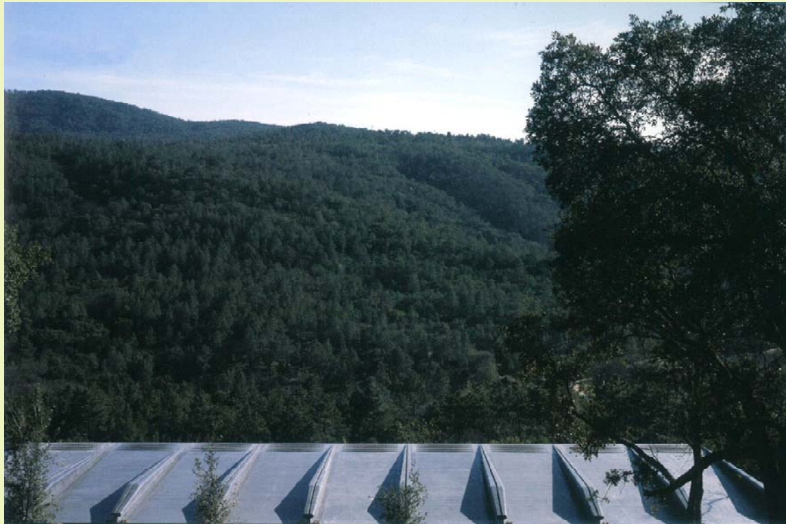
Abbildung 70: Draufsicht der überkragenden Dachkonstruktion der Villa Navarra
