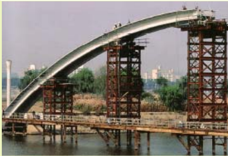
Abbildung 52: Montage der Seonyu Footbridge , Seoul/Korea, 2002
