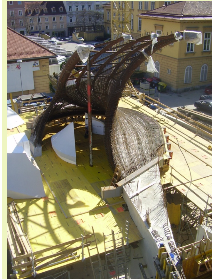
Abbildung 93: Foto: Convex; Stahlkonstruktion des Twists
