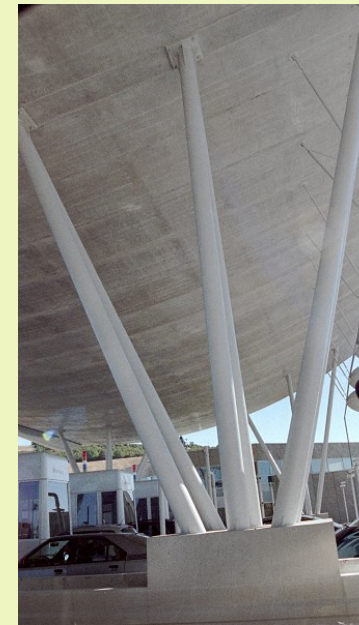
Abbildung 59: Fotograf: Nicolas Janberg, 2005: Untersicht der Betonschale
