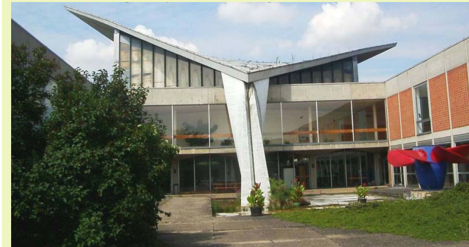
Abbildung 19: Hyperschale der FH Scheinfurt vor den Sanierungsarbeiten
