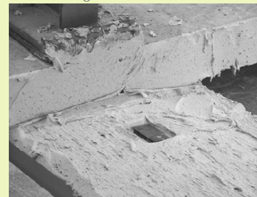
Abbildung 56: Klebemörtel (2 Komponenten Epoxidharz SIKADUR 30) auf den Obergurten und den Stirnseiten der Platten
