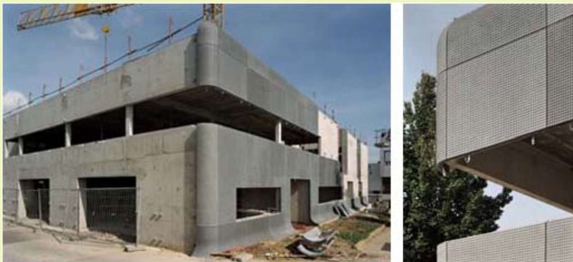
Abbildung 76: Gebäude der RATP in der Bauphase
