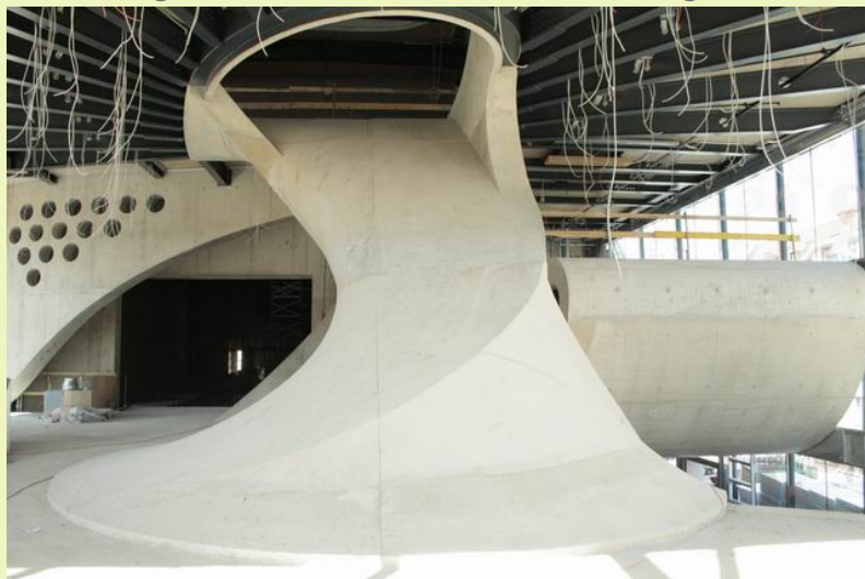
Abbildung 99: Foto: Convex; fertig ausgeschalteter Twist
