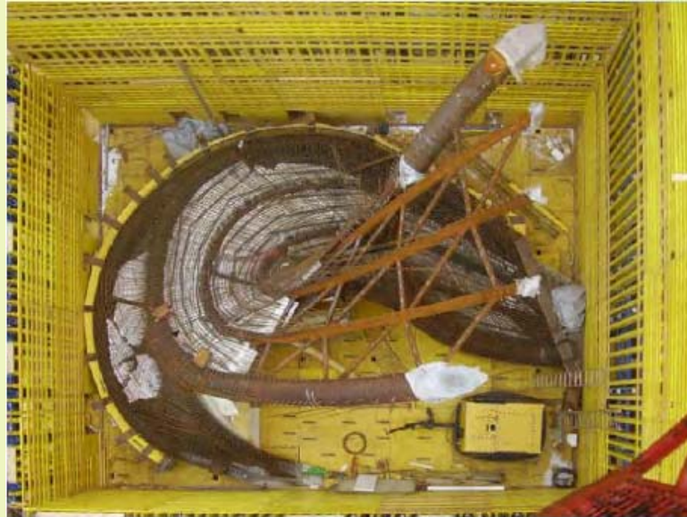
Abbildung 98: Hilfsgerüst/Ansicht von oben
