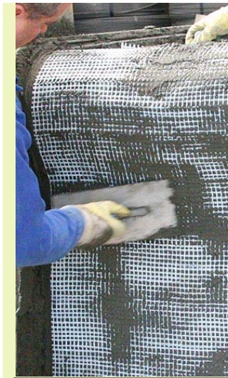
Abbildung 15: Herstellung von Textilbeton
