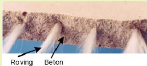
Abbildung 14: Einbettung von AR-Glasrovings eines Textils im Beton
