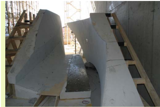
Abbildung 96: Foto: Convex; Schalungselemente aus Claroporon mit Holzkonstruktion
