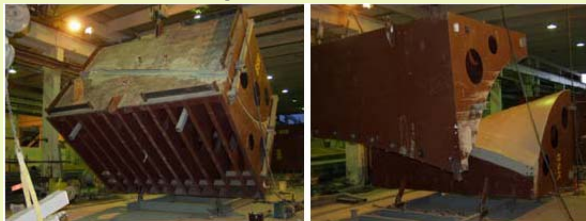
Abbildung 62: Schalungsprozess einer Halbschale 1
