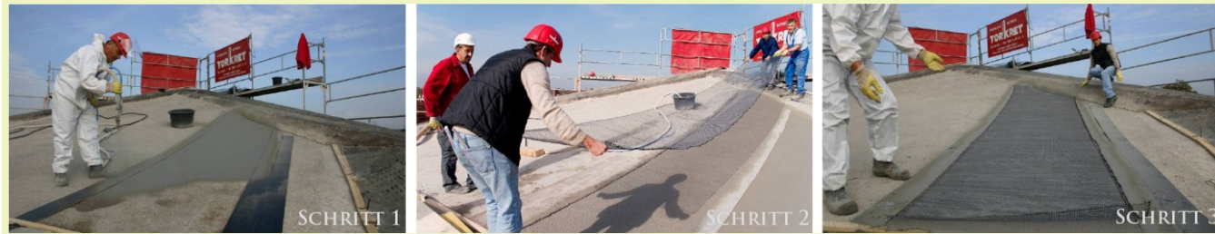
Abbildung 21: Aufbringen der textilen Verstärkungsstruktur auf die bestehende Dachkonstruktion
