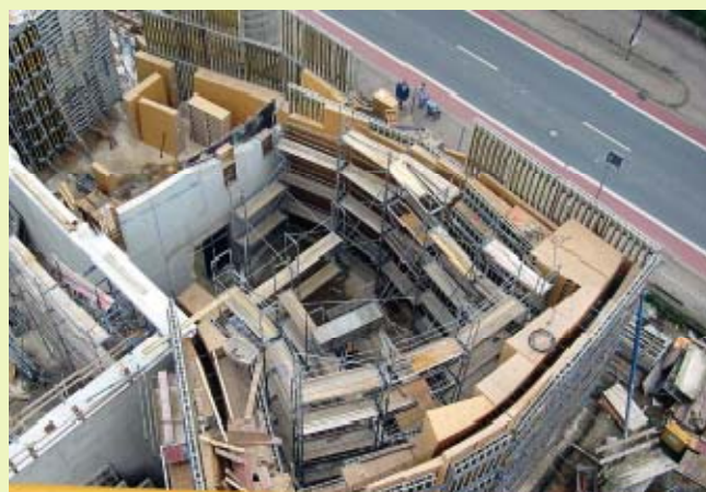
Abbildung 86: Baustelle in Herford beim Aufstellen der Schalung
