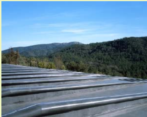
Abbildung 71: Dachkonstruktion der Villa Navarra
