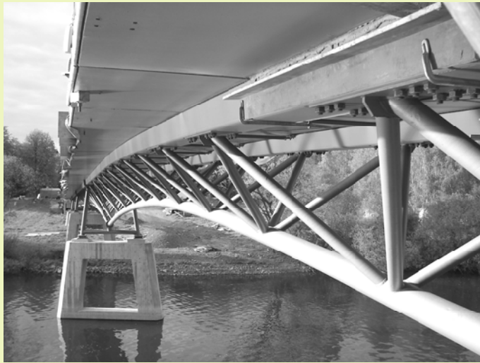
Abbildung 57: Aufkleben der Fahrbahnplatten auf die Obergurte: Untersicht mit Klebefuge einer frisch aufgelegten Platte im Vordergrund
