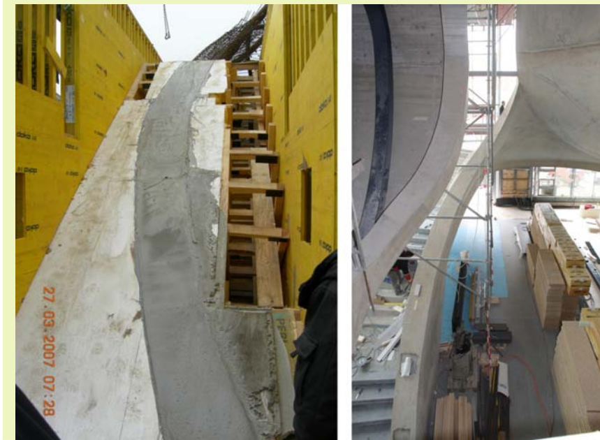
Abbildung 97: Foto: Convex; links: Betonwand mit Schalung; rechts: Betonwand ausgeschalt
