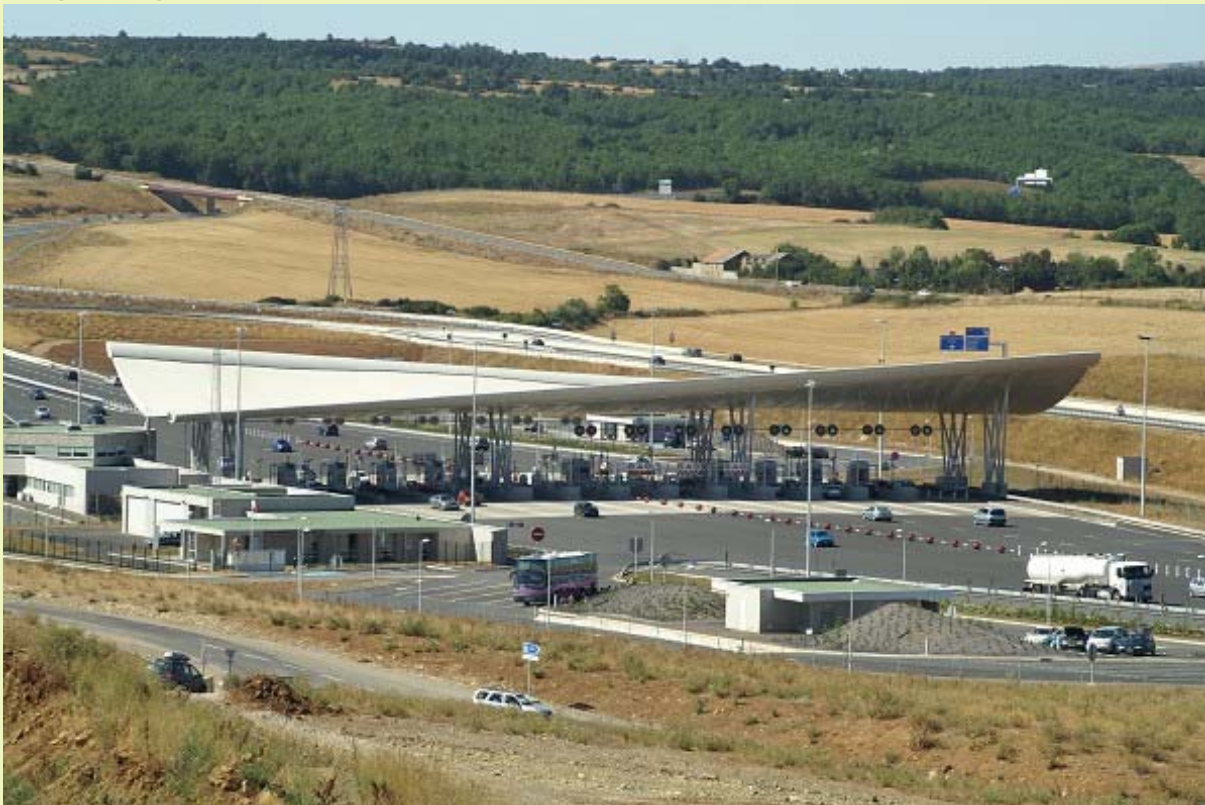
Abbildung 58: Fotograf: Nicolas Janberg, 2005: Mautstation des Millau Viadukts/ Millau/Frankreich
