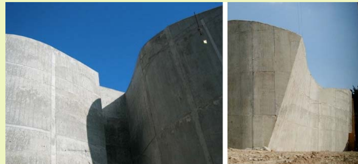
Abbildung 88: Freiformwandflächen aus Ortbeton nach dem Ausschalen
