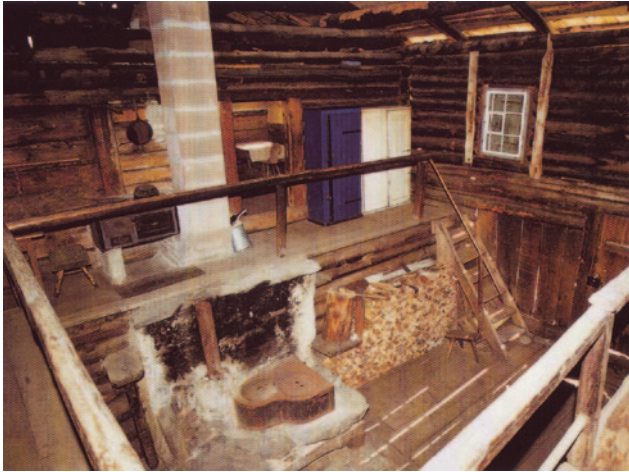
Käserei, Treppe zur Hauptgalerie, Feuerstelle mit Kochherd
